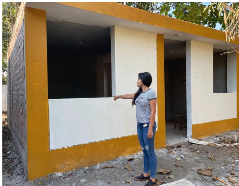
Figura 35: Verificación de vanos.
