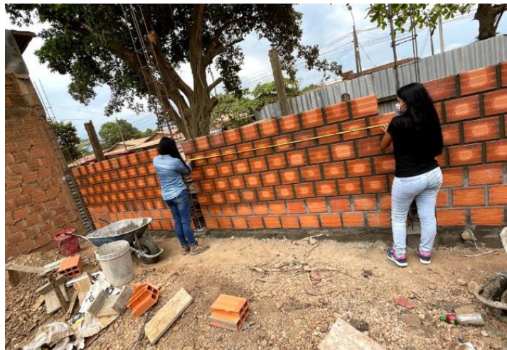
Figura 33: Medición de extremos de las paredes.
