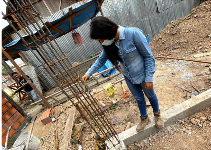
Figura 32: Medición de las columnas.
