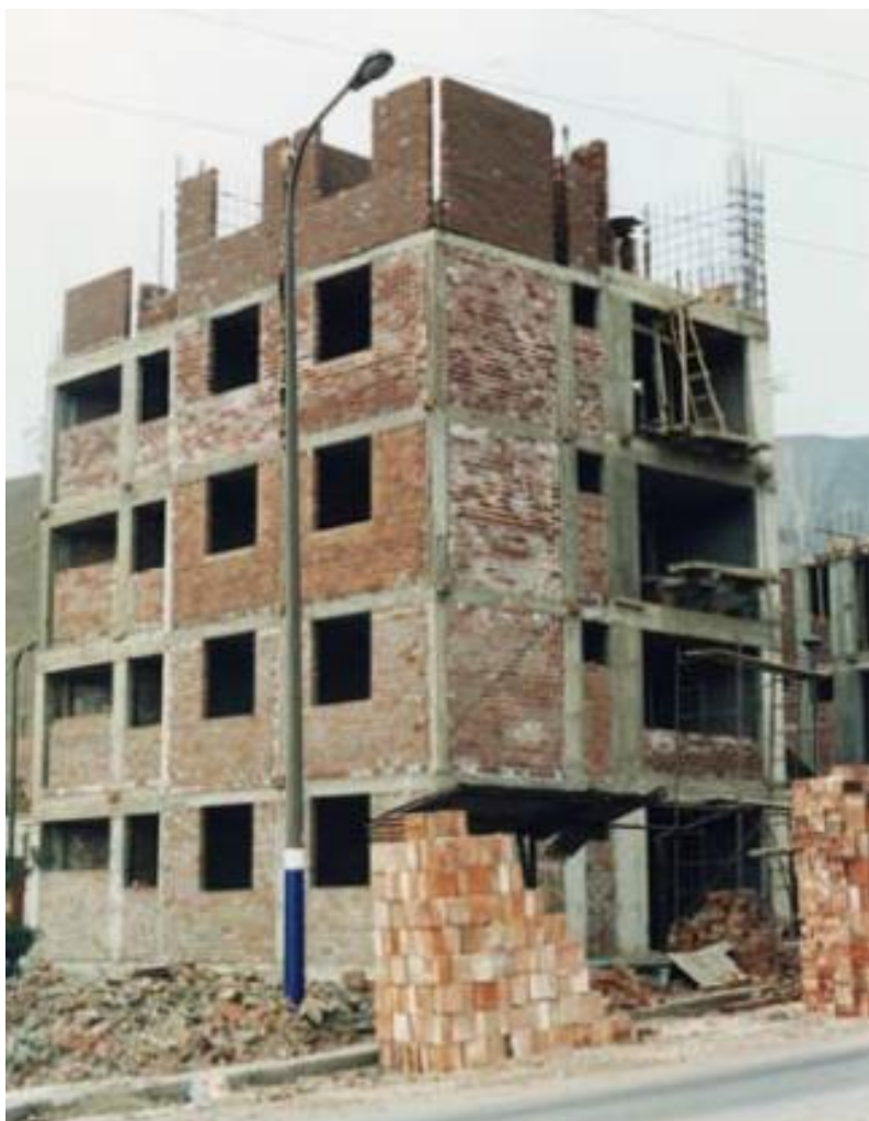
Figura 6: Edificación de Albañilería Confinada
