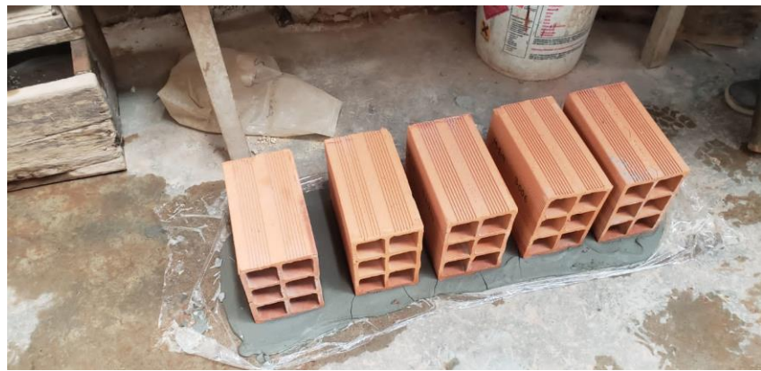
Figura 26: Primera capa ligera de cemento y yeso.
