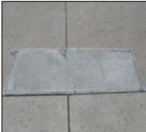
Figura N°68: Parcheo menor de severidad media
