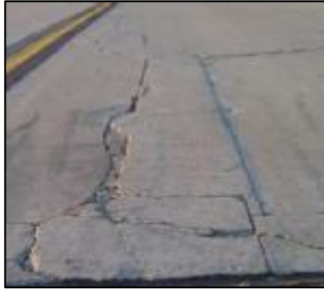
Figura N°71: Parcheo mayor de severidad alta
