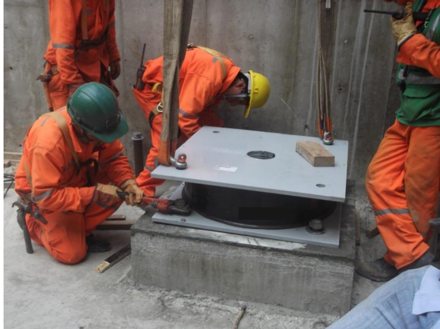
Figura 141. Ajuste manual de pernos inferiores (Caso en zona de PIT de ascensores)
