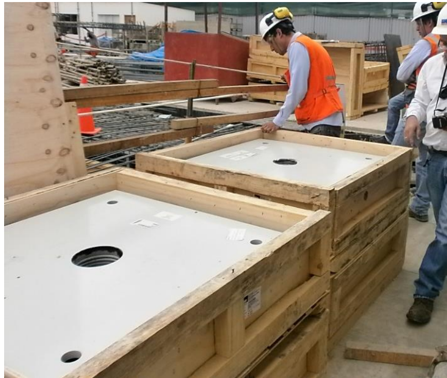
Figura 134. Inspección de aisladores para montaje.
