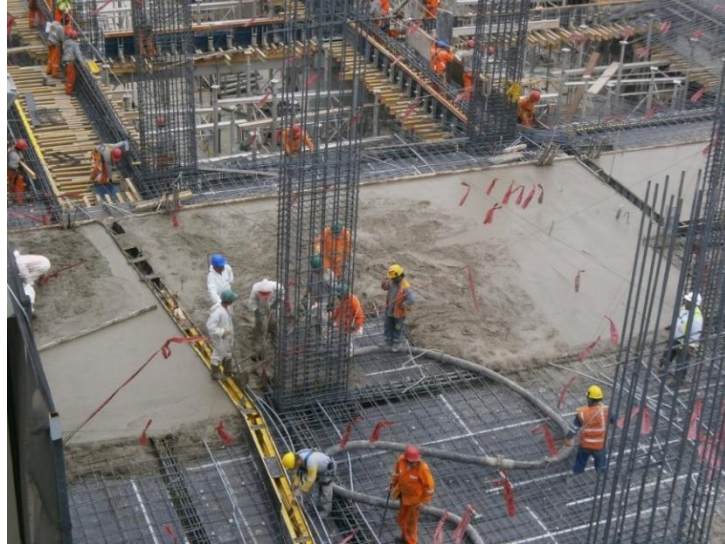
Figura 149. Vaciado de capitel superior, vigas y losa (Caso Nivel +/- 0.00)
