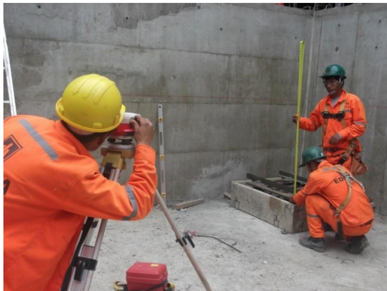
Figura 127. Nivelación de capitel inferior (Caso en zona de PIT de ascensores)
