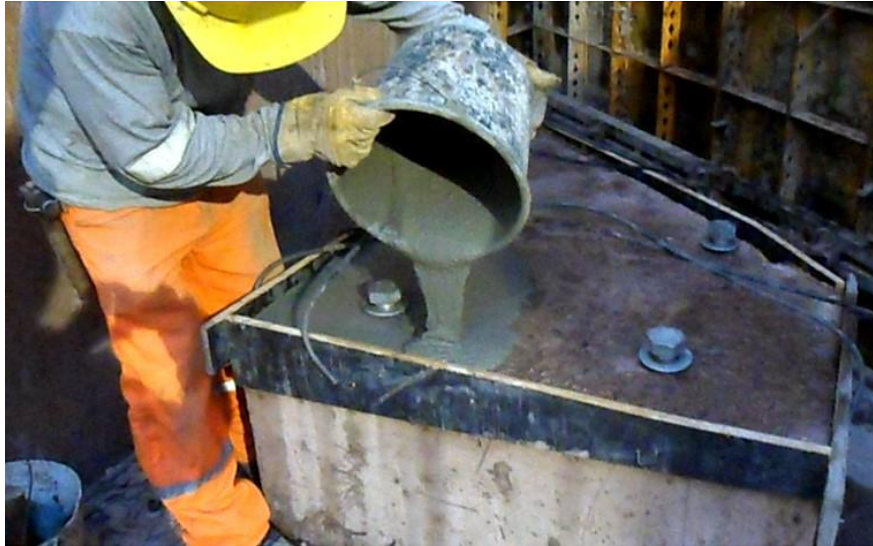
Figura 130. Colocación del grout (Caso en zona de PIT de ascensores)
