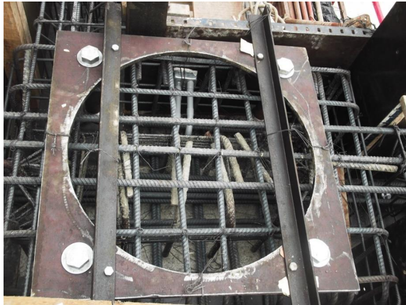
Figura 125. Acople de machina y conectores a los aceros del capitel (Caso Nivel de Aislamiento)
