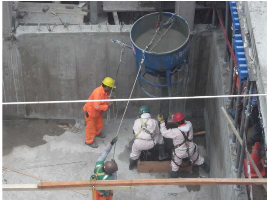
Figura 128. Vaciado de capitel (Caso en zona de PIT de ascensores)
