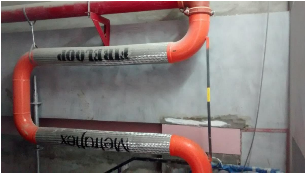
Figura 35 Conexión flexible entre tuberías (FEMA 414)
