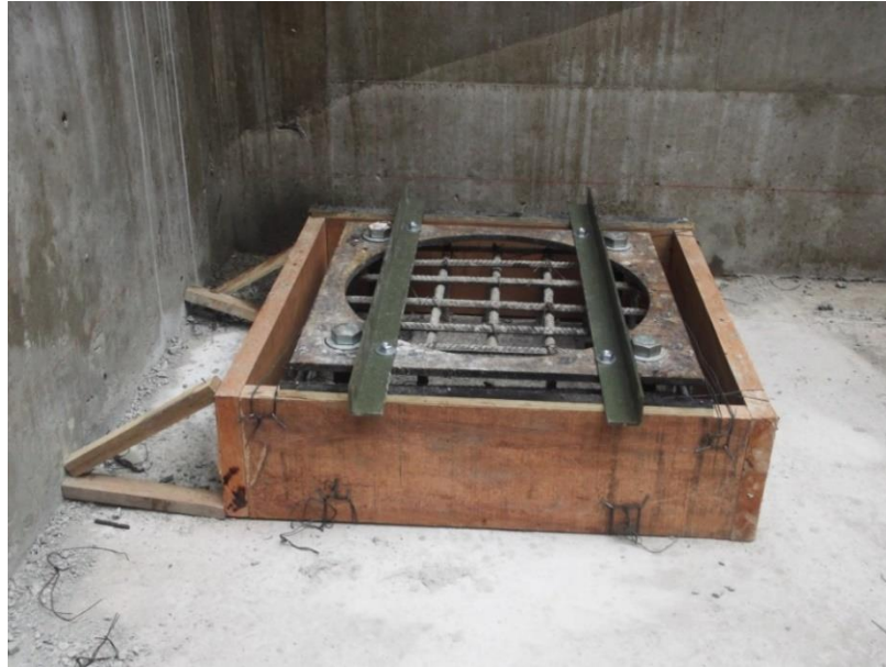
Figura 126. Encofrado de capitel inferior (Caso en zona de PIT de ascensores)
