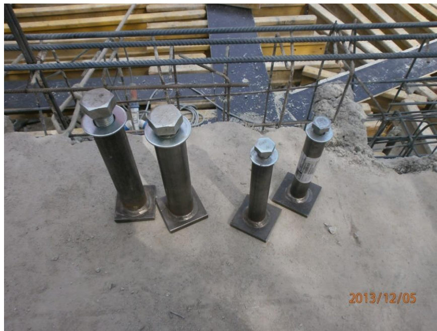
Figura 143. Armado de conectores de anclaje y pernos.
