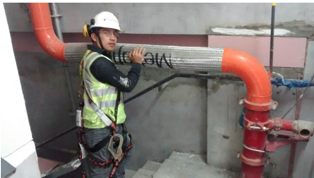
Figura 36. Conexión flexible entre tuberías (FEMA 414)
