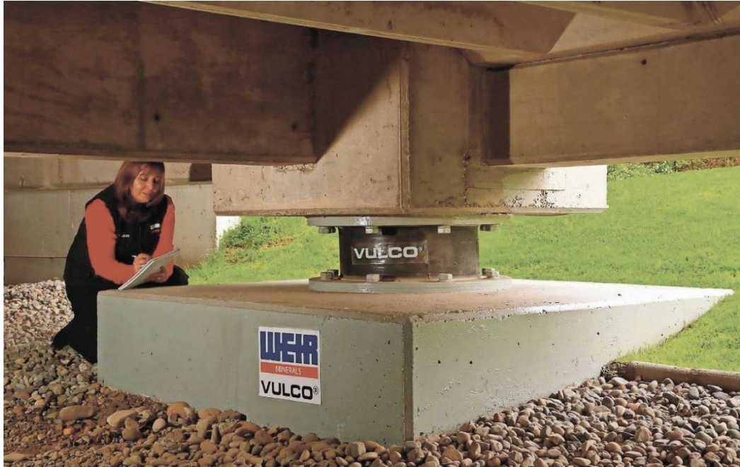
Figura 115. Aislador debajo del primer nivel de la estructura sin presencia de sótanos.
