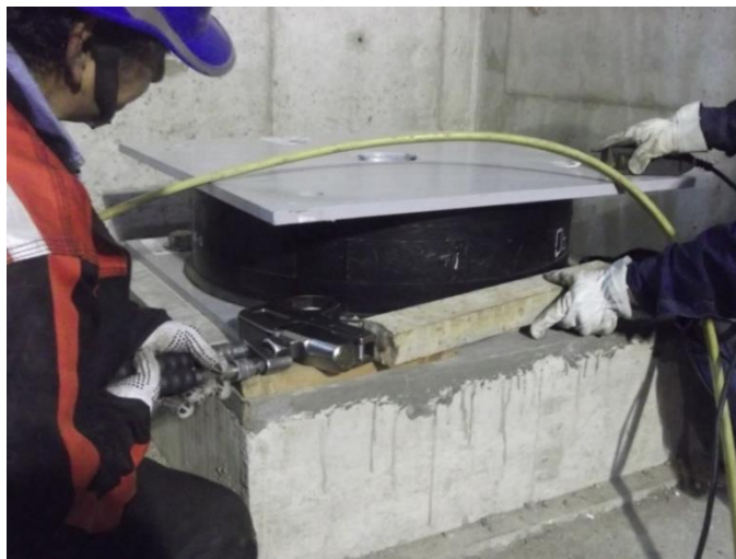
Figura 145. Ajuste de pernos con equipo electrónico (Caso en zona de PIT de ascensores)
