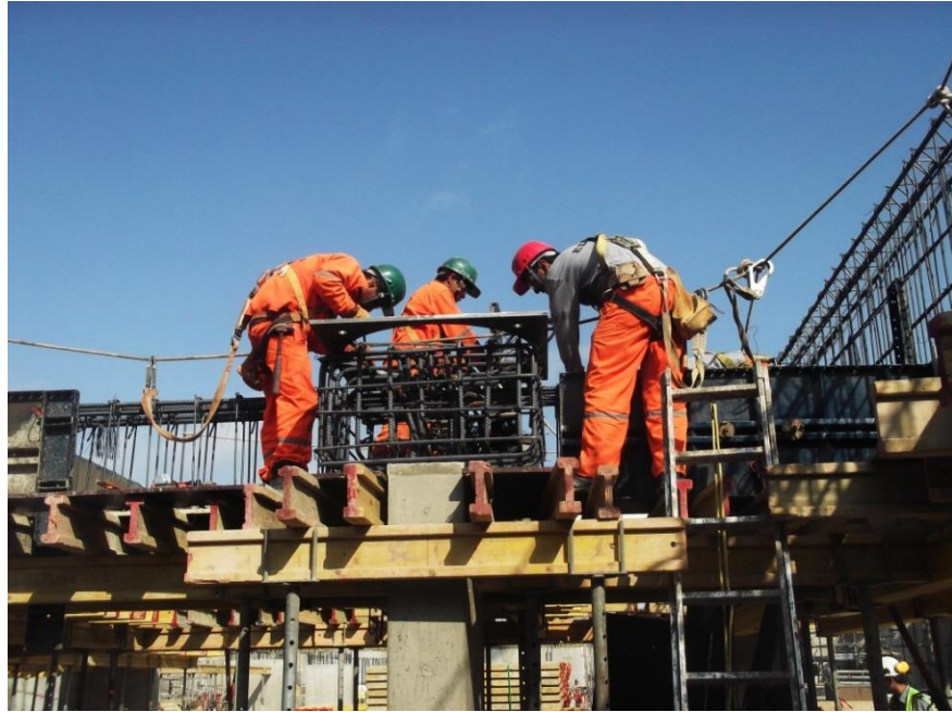
Figura 122. Habilitación de acero para capitel inferior y emplantillado de machina (Caso Nivel de Aislamiento)
