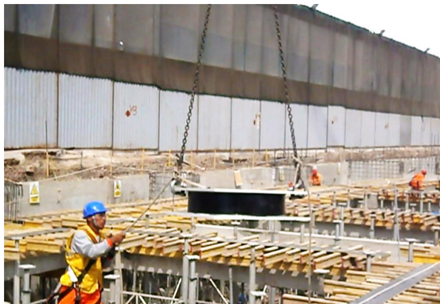
Figura 138. Colocación de aisladores (Caso Nivel de Aislamiento)
