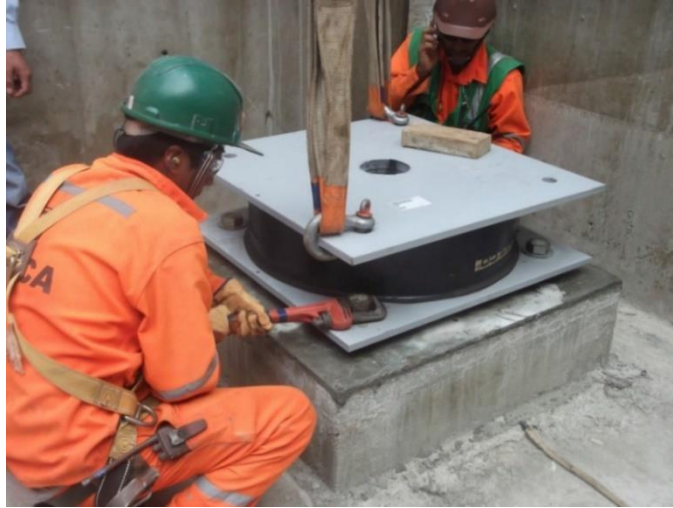
Figura 144. Ajuste de pernos manuales (Caso en zona de PIT de ascensores)
