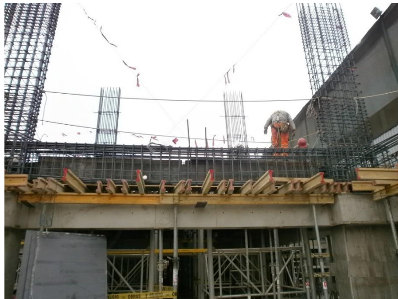
Figura 148. Armado de acero en capitel superior, vigas y columnas (Caso Nivel +/- 0.00.)
