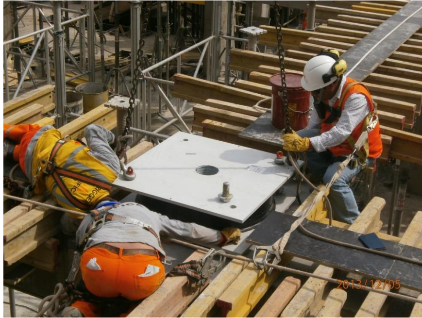
Figura 139. Colocación de aisladores (Caso Nivel de Aislamiento)
