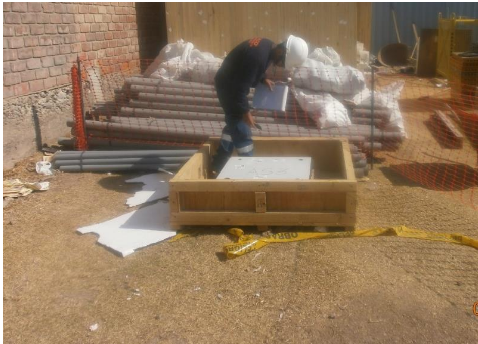
Figura 120. Verificación del estado de los dispositivos (deslizadores).
