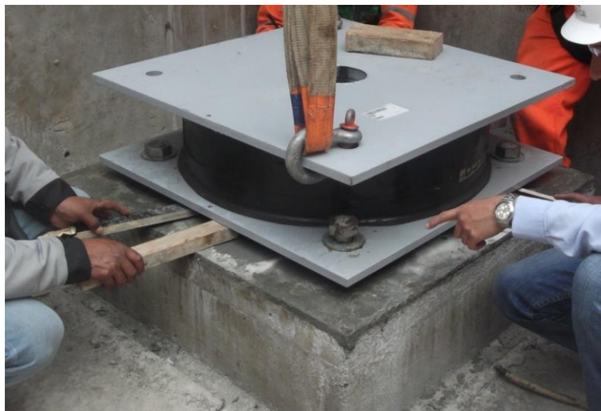
Figura 140. Colocación de tacos de madera para amortiguamiento (Caso en zona de PIT de ascensores)
