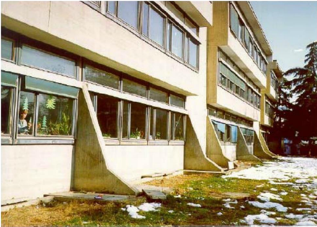
Figura 2. Primary School Pestalozzi, parte del edificio aislado.
