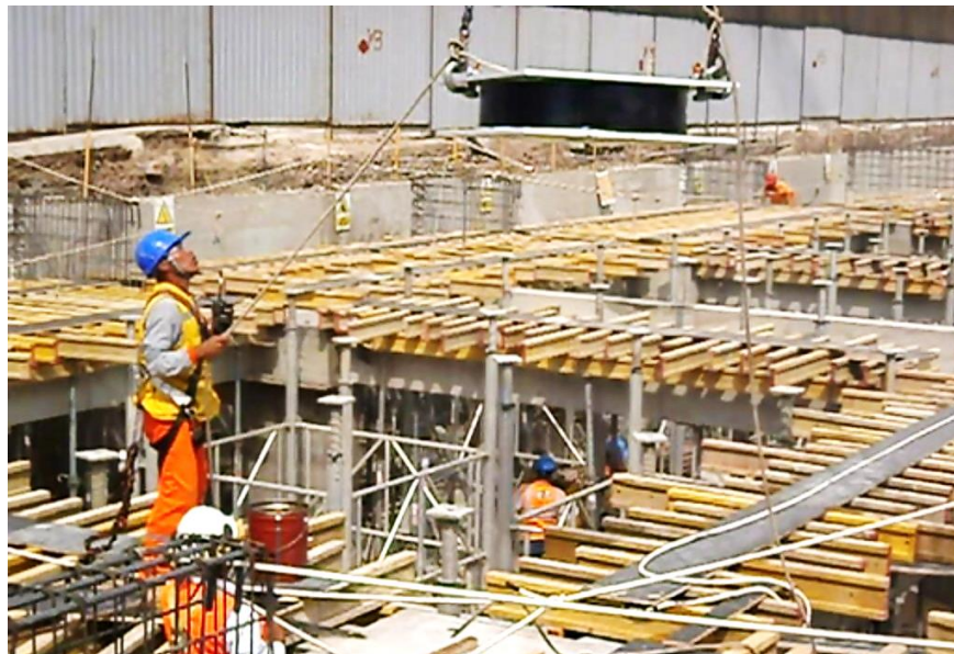
Figura 137. Izaje y colocación de aisladores (Caso Nivel de Aislamiento)
