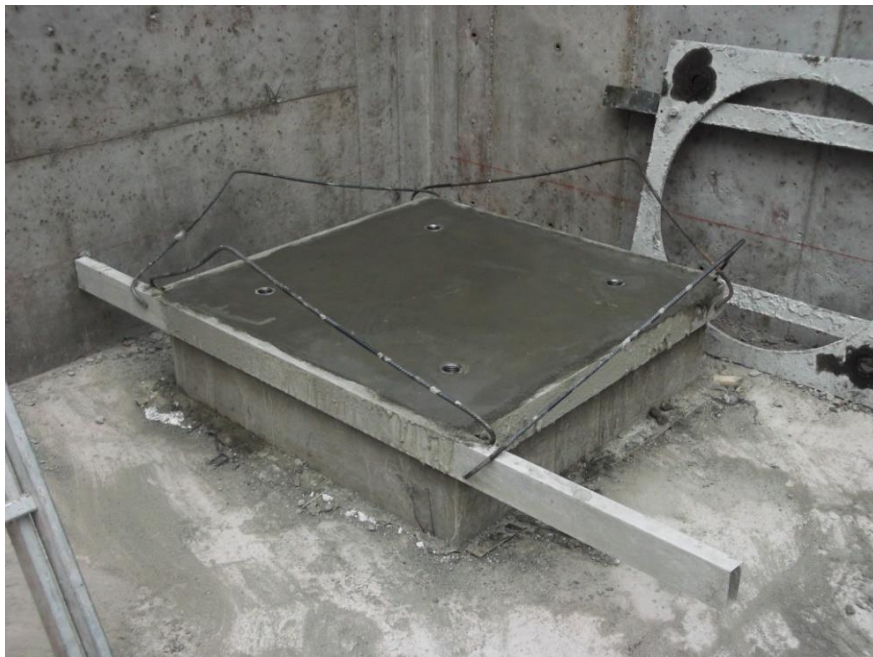
Figura 131. Fraguado de grout (Caso en zona de PIT de ascensores)
