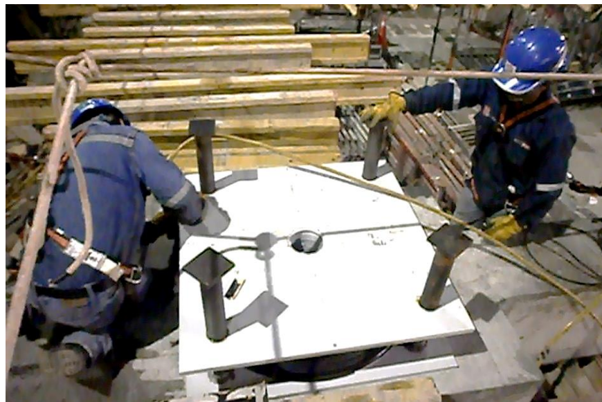
Figura 146. Colocación de conectores superiores de anclaje (Caso Nivel de Aislamiento)
