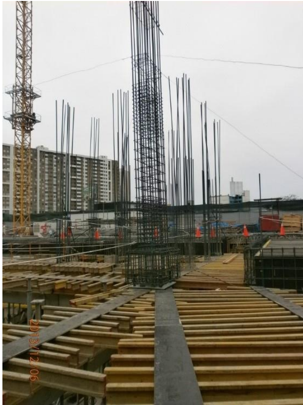
Figura 147. Armado de acero en capitel superior y columnas (Caso Nivel de Aislamiento)
