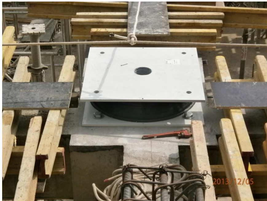
Figura 142. Ajuste manual de pernos inferiores (Caso Nivel de Aislamiento)
