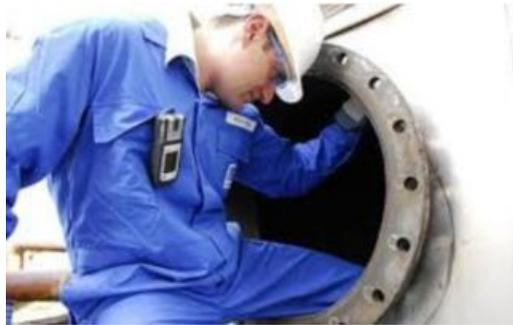
Figura 25. Medición de gases en espacios confinados
