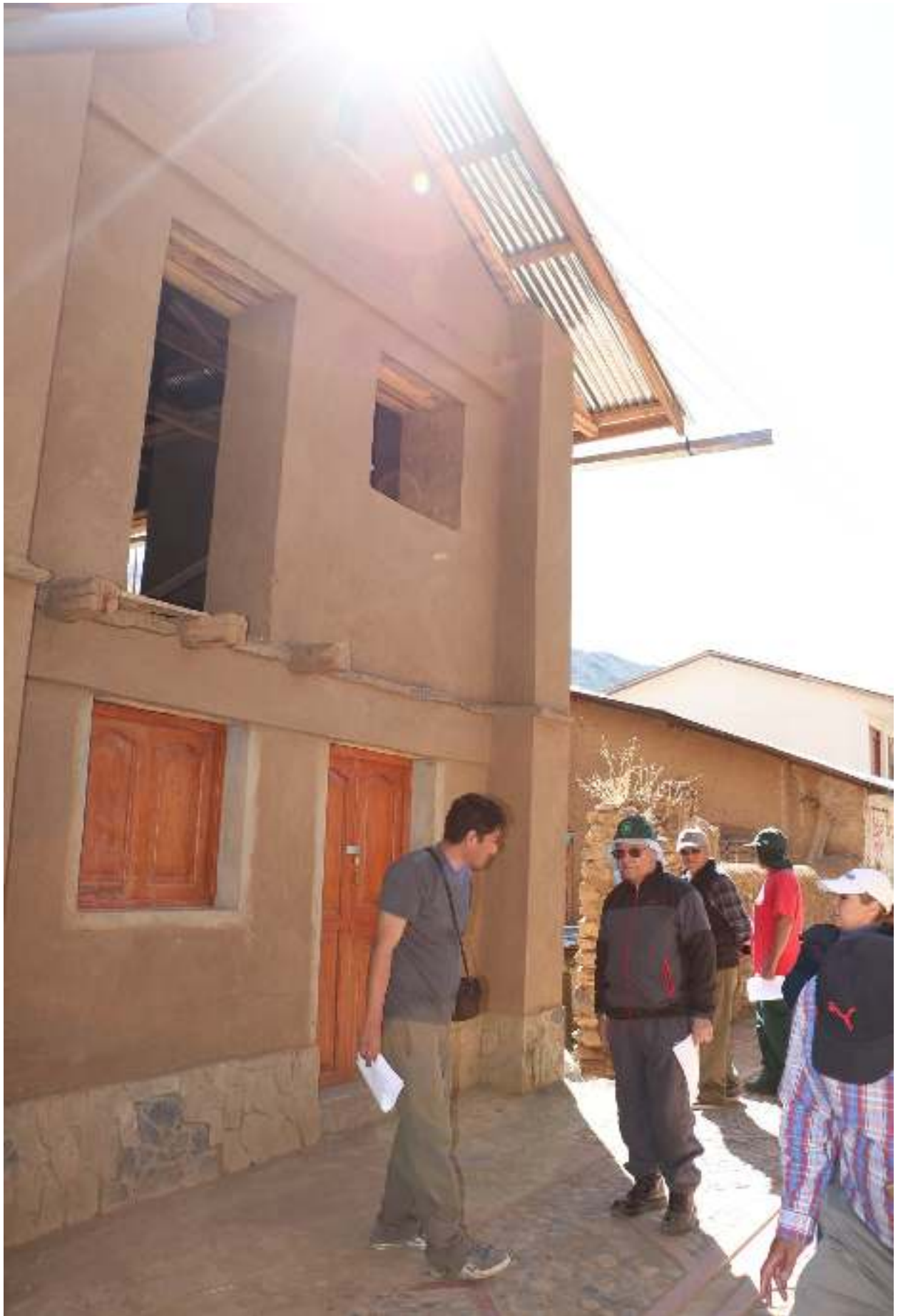
Algunos inmuebles antiguos están siendo derruidos para levantar nuevas edificaciones no siempre respetando la volumetría y entorno monumental.
