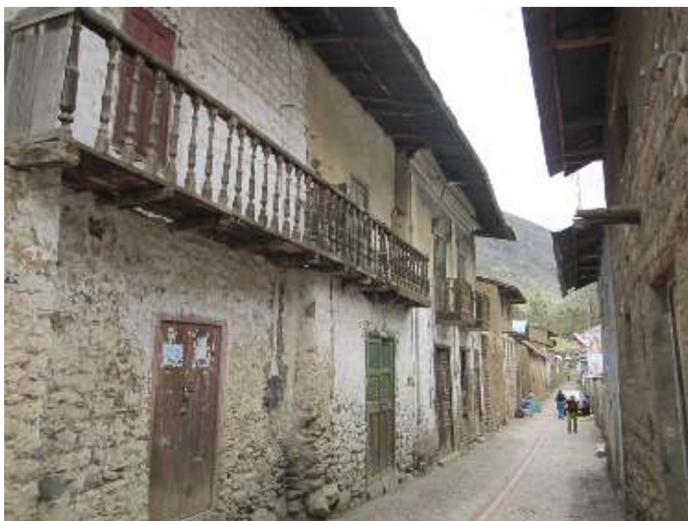
FIGURA N°60 Viviendas tipo urbano Fuente: Propia
