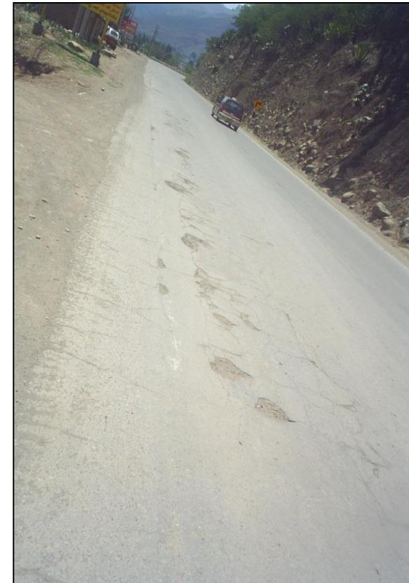
Presencia de “Parches y Piel de Cocodrilo”. Vista del entorno de la carretera dañada. Superficie dañada con “Huecos” y “Grietas”.
