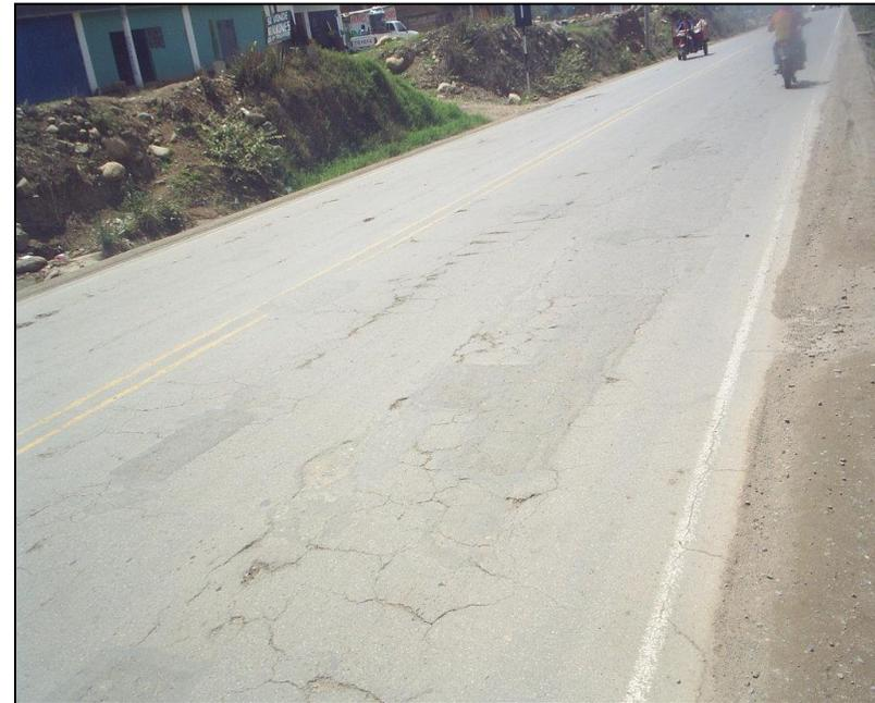
Superficie de rodamiento de notable deterioro.
