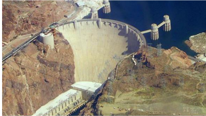
Figura N° 18: Presa de arco
