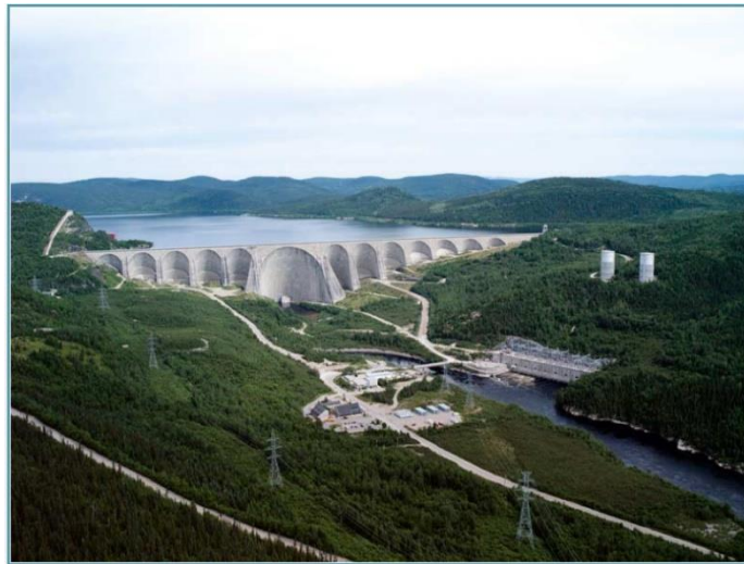
Figura N° 20: Presa de arcos múltiples
