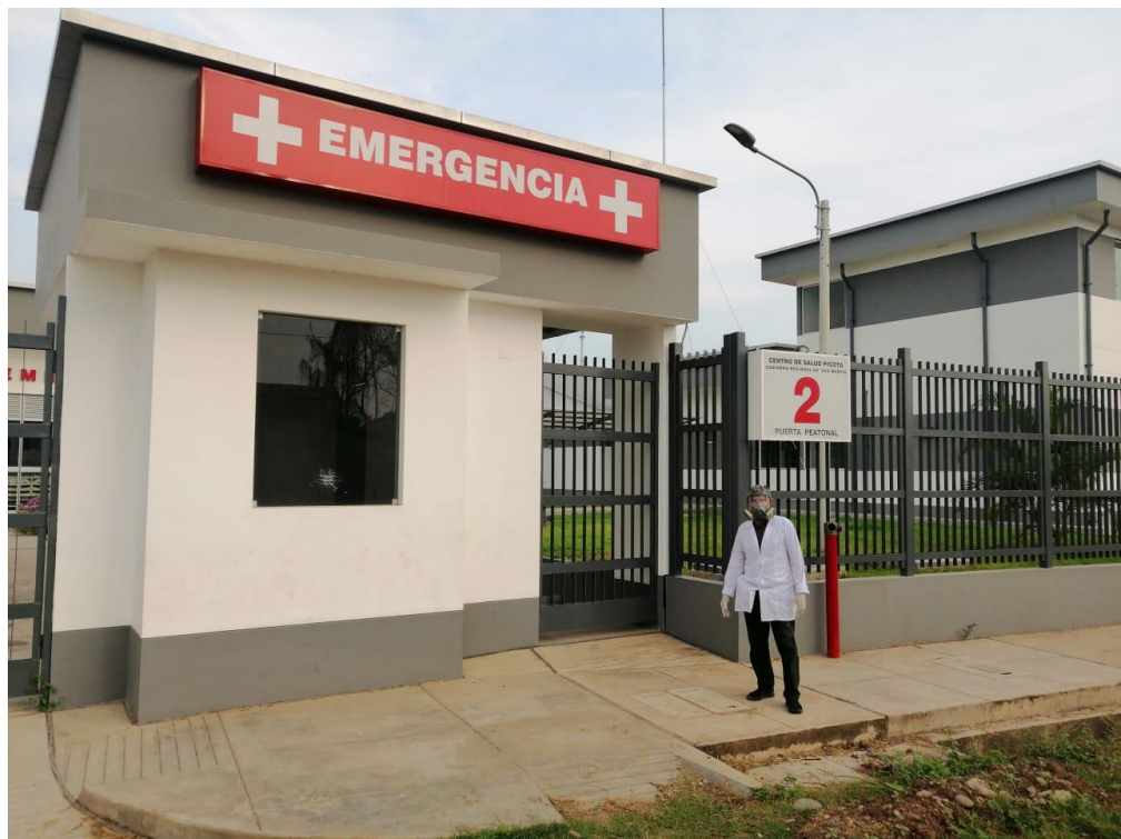
Figura N°25: Ingreso a Emergencias – Centro Salud Picota.
