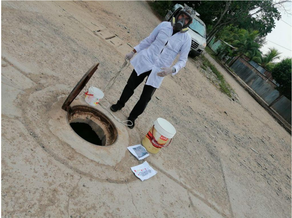
Figura N°26: Buzón colector del hospital de Picota.
