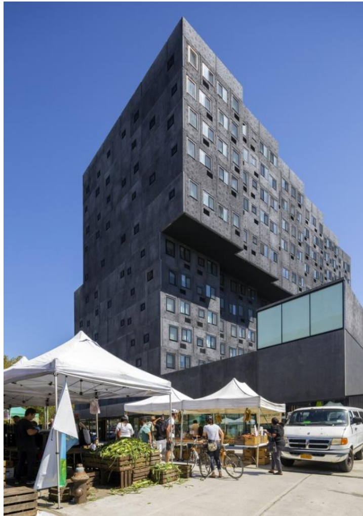
Figura 21. Edificio Sugar Hill Development en Manhattan, Nueva York. Fotografía de Wade Zimmerman (2015).
