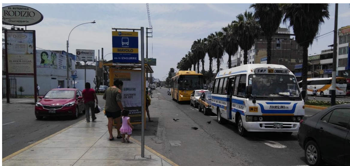
Figura 80. Paradero del alimentador AN-18 en la avenida Carlos Izaguirre siendo usado por otras empresas de transporte del “sistema tradicional de transporte”, en la intersección de las avenidas Carlos Izaguirre y Antúnez de Mayolo, en el sentido de Universitaria a Túpac Amaru en Los Olivos, Lima. 15 de febrero del 2018.
