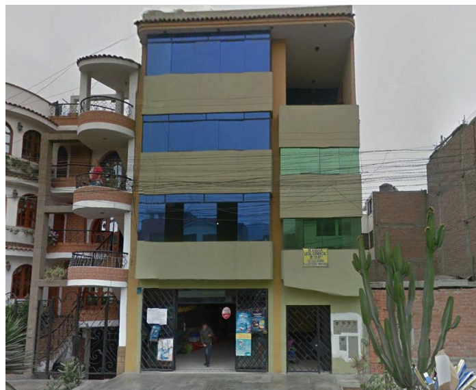
Fig.57. Google Earth. Lima, Perú, 2016. Oficina en La Molina, Ca. Sta Cruz de Tenerife
