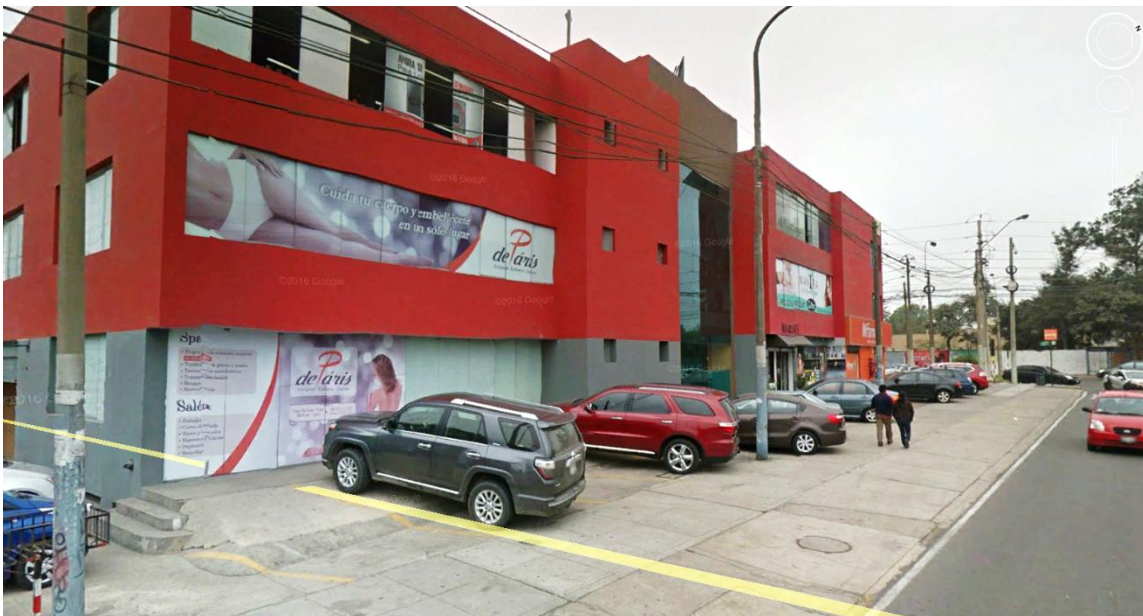
Fig.62. Elaboración propia. Lima, Perú, 2016. Vista del terreno desde la Av. Los Fresnos.
