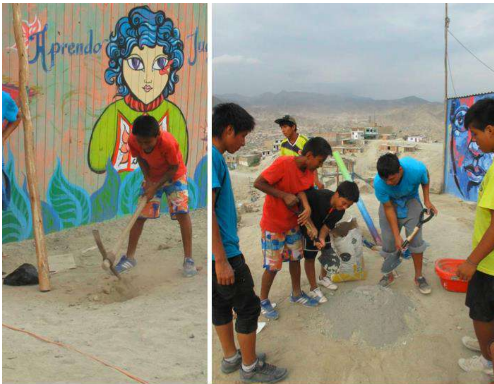
Figura N°71: Taller de construcción Ruwasunchis
