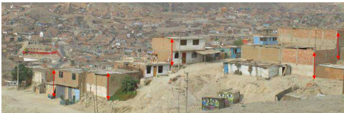
Figura N°35: Vivienda de 2 pisos Fuente: Propia (25 de Agosto del 2017).
