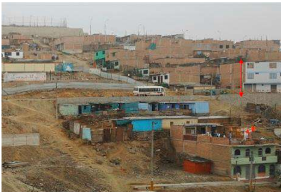
Figura N°36: Vivienda de 3 pisos Fuente: Propia (25 de Agosto del 2017)
