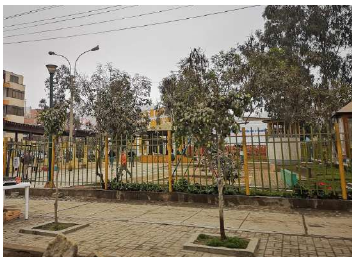
Figura N°37: ZRP Habilitada con acceso restringido
