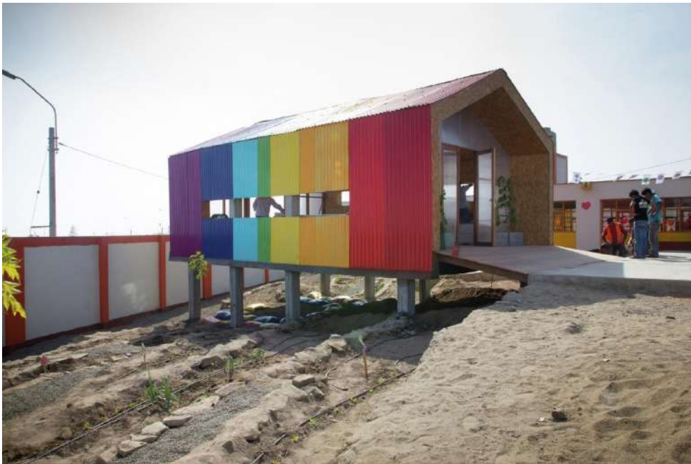
Figura N°19: Arcoíris en el Desierto – Huerto y Cocina Escolar
