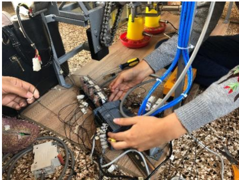
Vista del PLC Y Cableado
