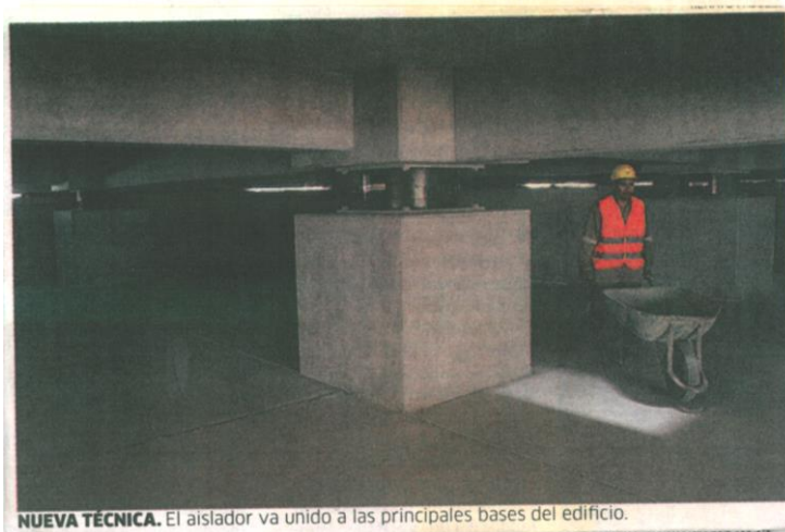
Ilustración 87 Aislador sísmico
