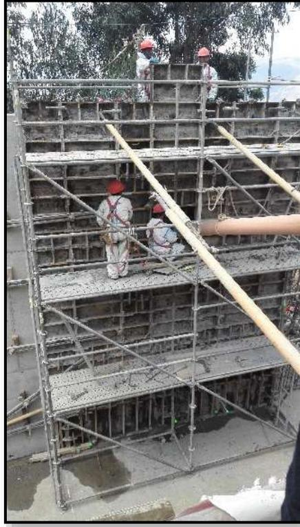
**Figura 21.** Proceso constructivo de muro de contención  $f'c$  210 kg/cm<sup>2</sup>.
