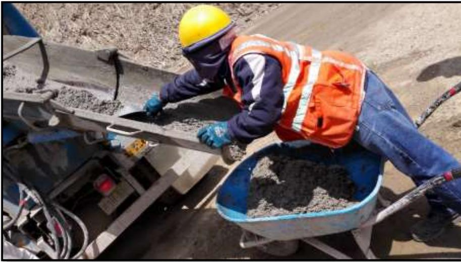
**Figura 11.** Concreto hidráulico en obra antes de vaciado.
