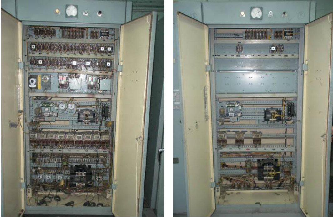
Figura D.4 Tablero de control antes y después de la instalación de PLC (Fuente: Ibídem)
