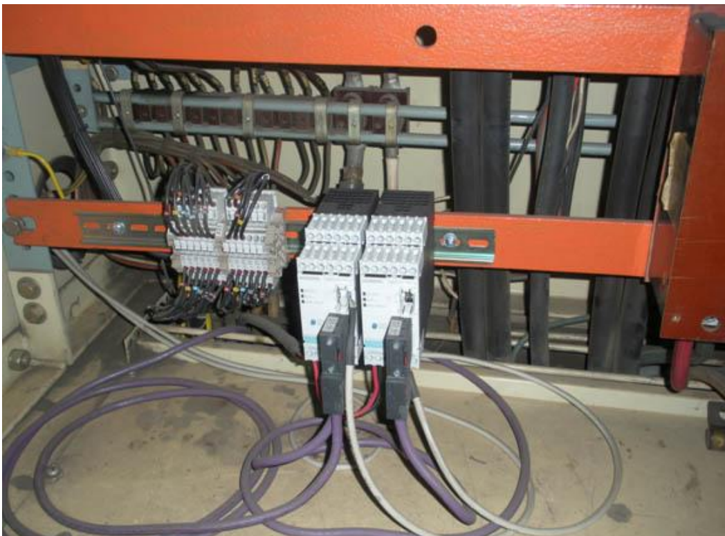
Figura D.20 Instalación Simocode (Fuente: Ibídem)
