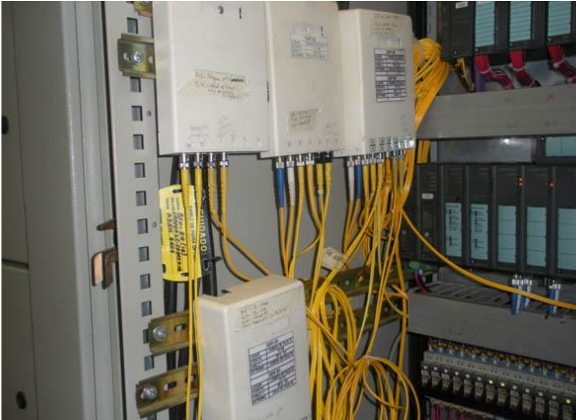
Figura D.21 Nodo Central – Red Ethernet Parte Alta (Fuente: Ibídem)
