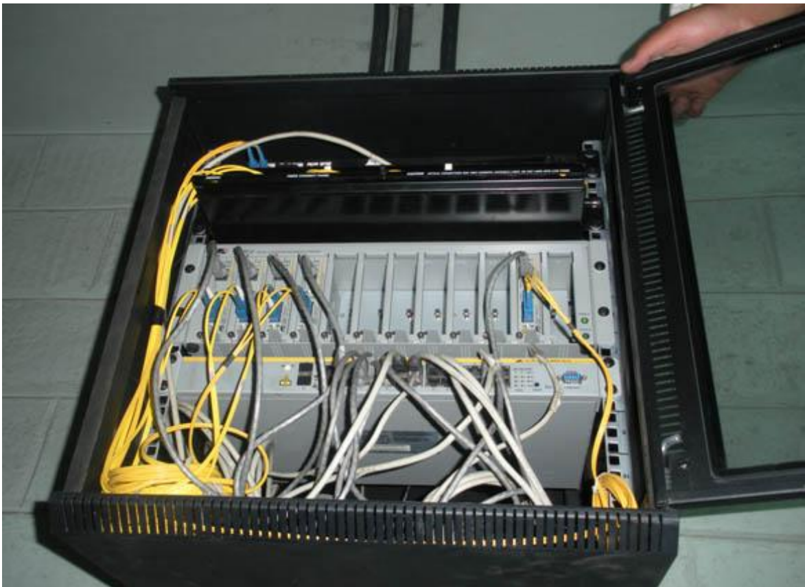
Figura D.12 Montaje Tablero Fibra - Ethernet (Fuente: Ibídem)
