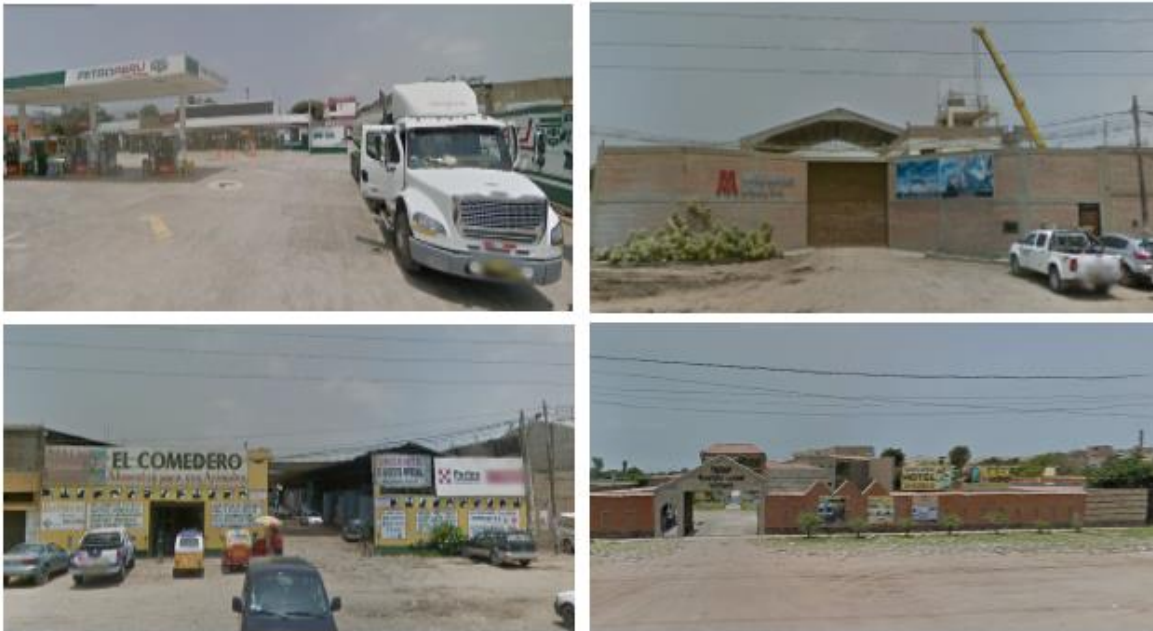
Figura 69. Entorno del lote seleccionado. Fuente: Elaboración propia.
