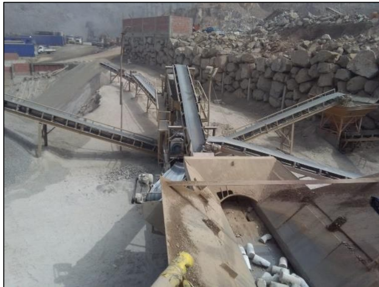
Figura 9 Triturado de las probetas de concreto
