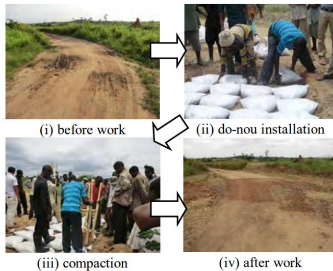
Figura N°06: Trabajos de construcción del Método Do-nou en Ghana.
