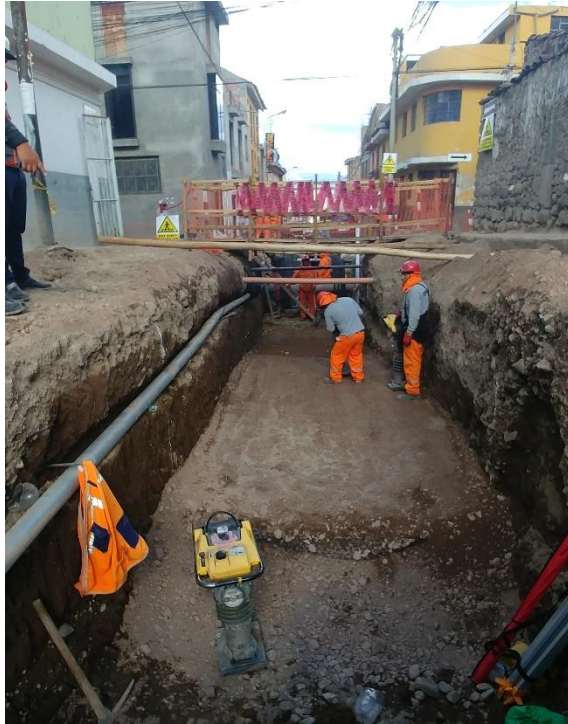
Foto 30. Trabajos de conformación de base para canal de drenaje.
