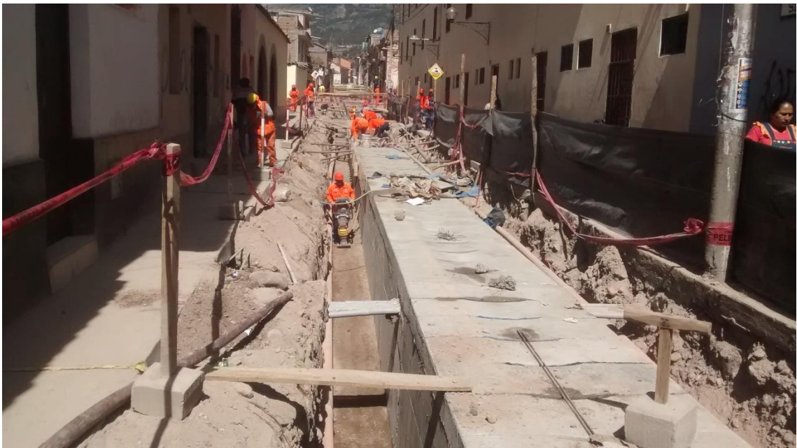
Foto 24. Instalación de redes de alcantarillado.
