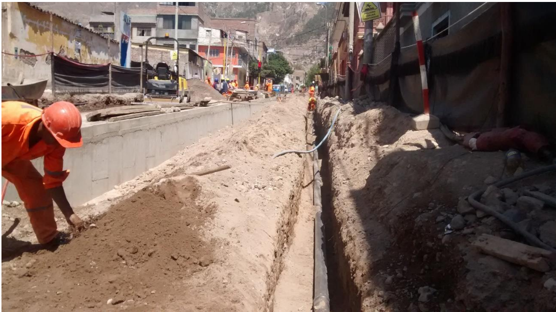
Figura 30. Instalación de redes de agua potable. Jr. Manco Cápac.
