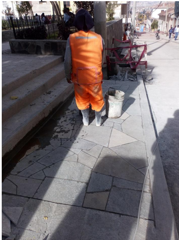
Foto 37. Trabajos en veredas.
