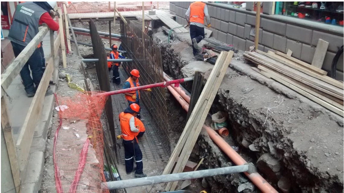
Foto 20. Instalación de acero para canal de drenaje.
