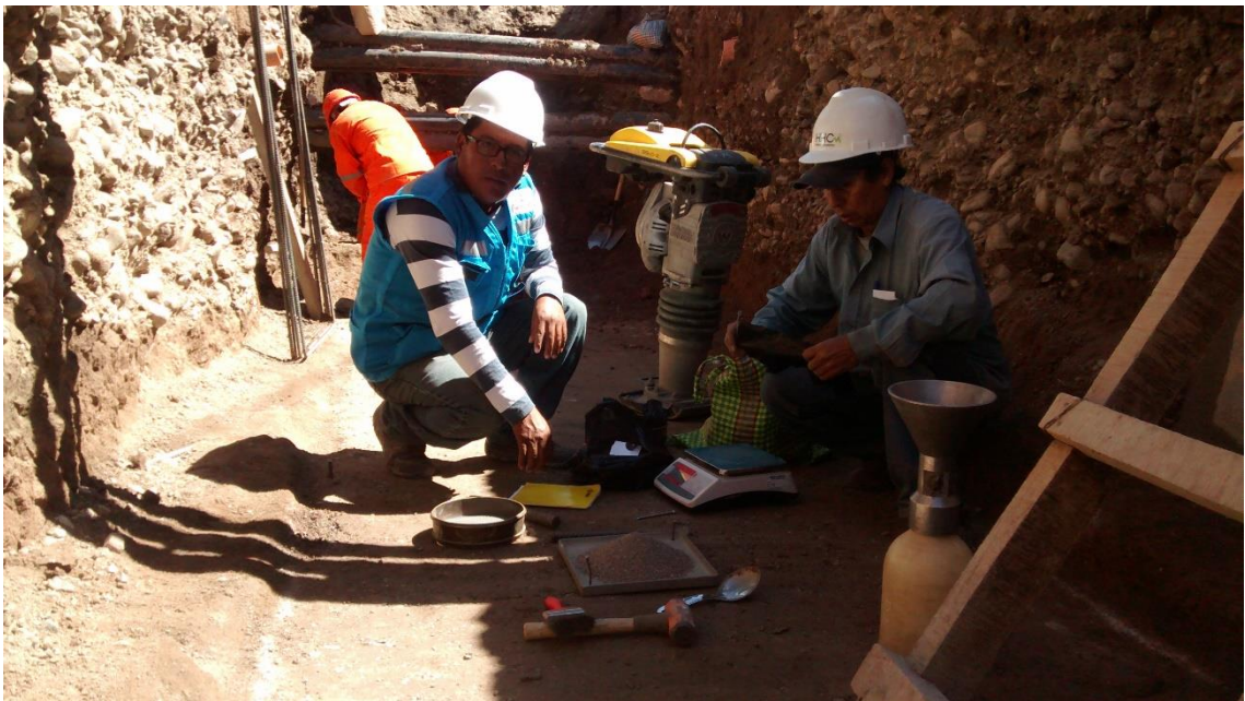
Foto 08. Controles de calidad en compactación.
