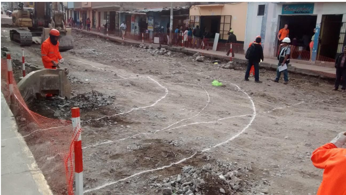
Foto 04. Trazo de canal para excavación masiva.
