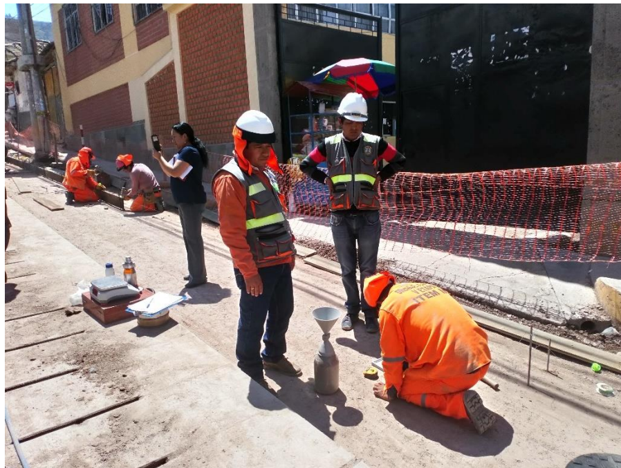
Foto 35. Ensayos de calidad de compactación de relleno controlado y base para pavimento.
