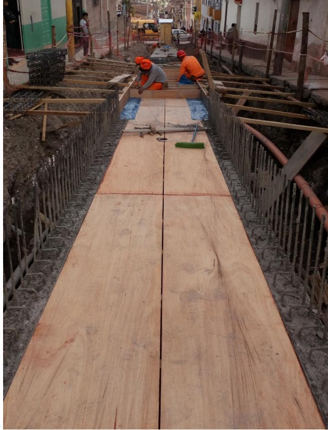
Figura 28. Encofrado de techo de canal. Jr. Lima cuadra 03.
