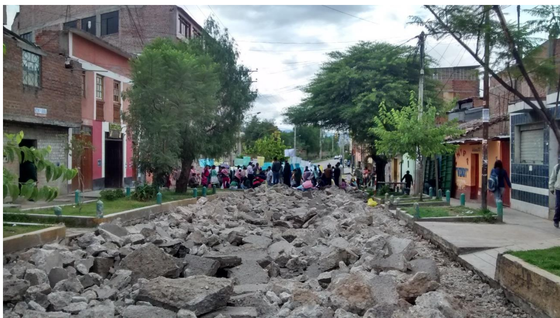
Foto 02. Demolición de pavimento y reclamo de vecinos por falta de comunicación.
