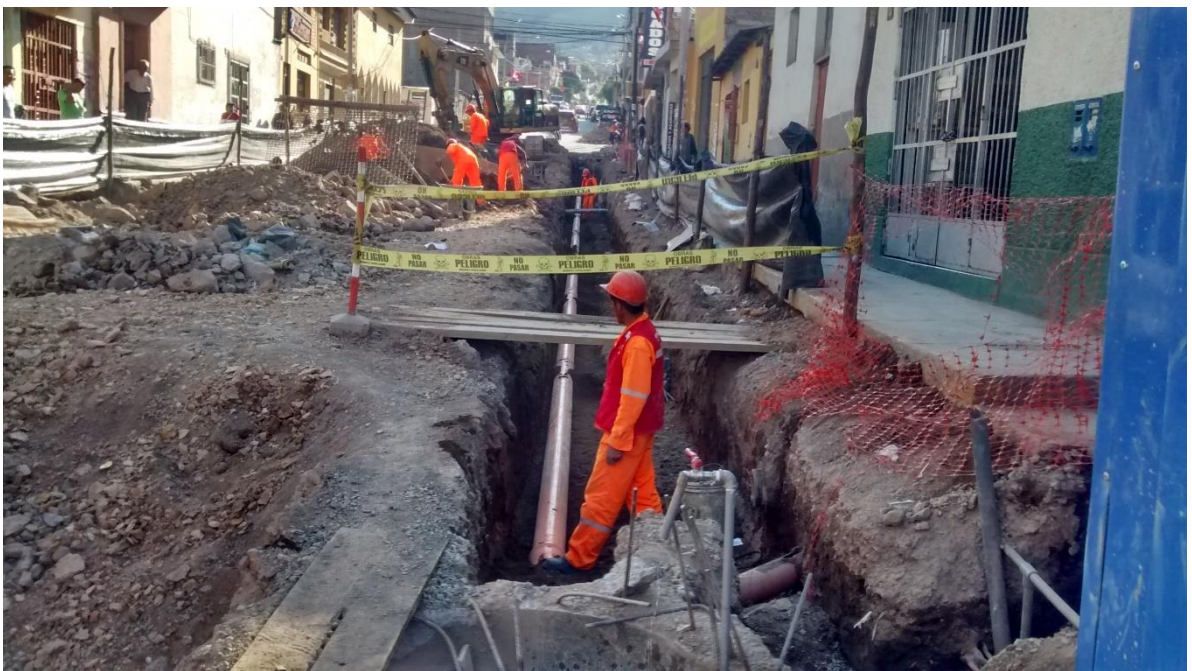
Foto 14. Instalación de nuevas redes de alcantarillado..
