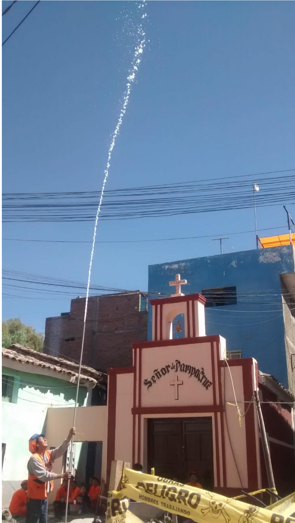
Foto 27. Prueba hidráulica a redes nuevas de agua potable.
