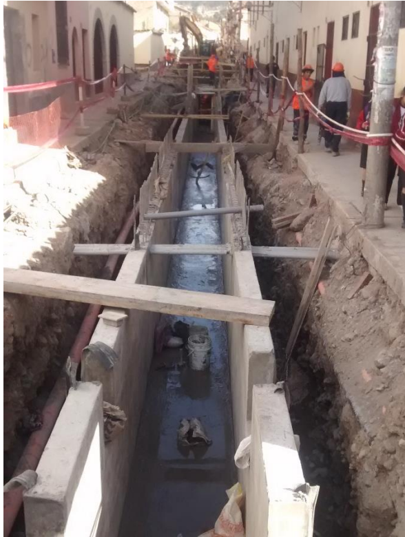
Foto 25. Trabajos de instalación de redes de alcantarillado..
