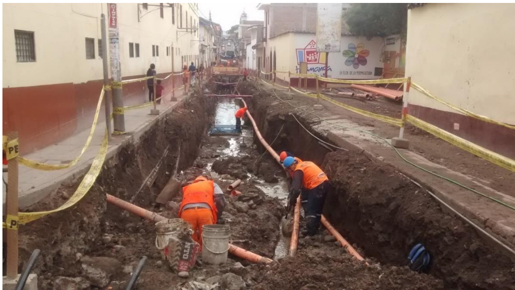
Figura 17. Limpieza de corte para canal de drenaje pluvial. Jr. 2 de mayo.
