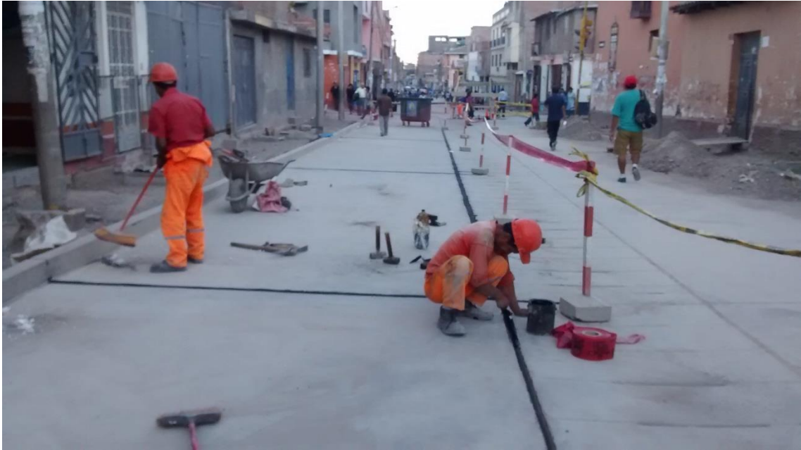
Foto 15. Instalación de juntas de brea en pavimento.
