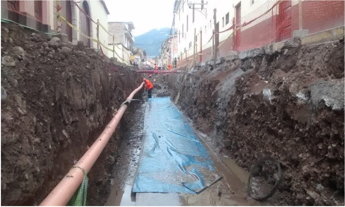
Figura 20. Protección de base y solado fresco para estructura de drenaje pluvial. Jr. 2 de mayo
