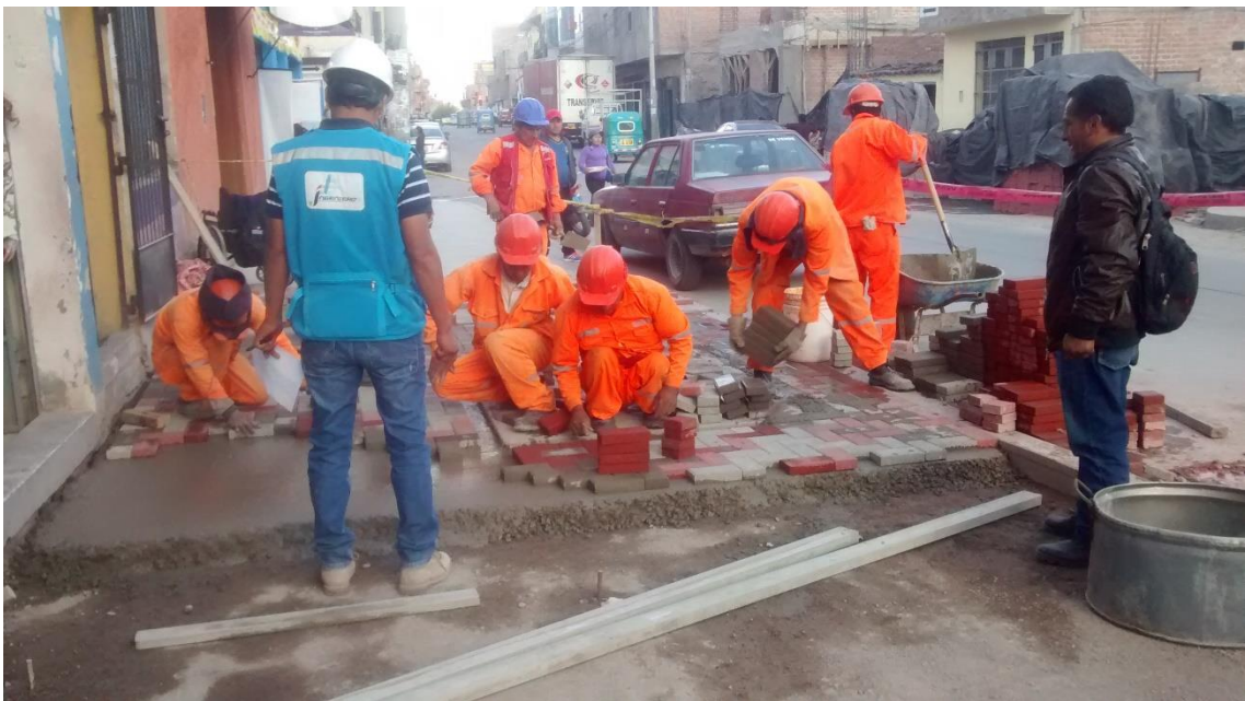
Foto 16. Instalación de adoquines en veredas.
