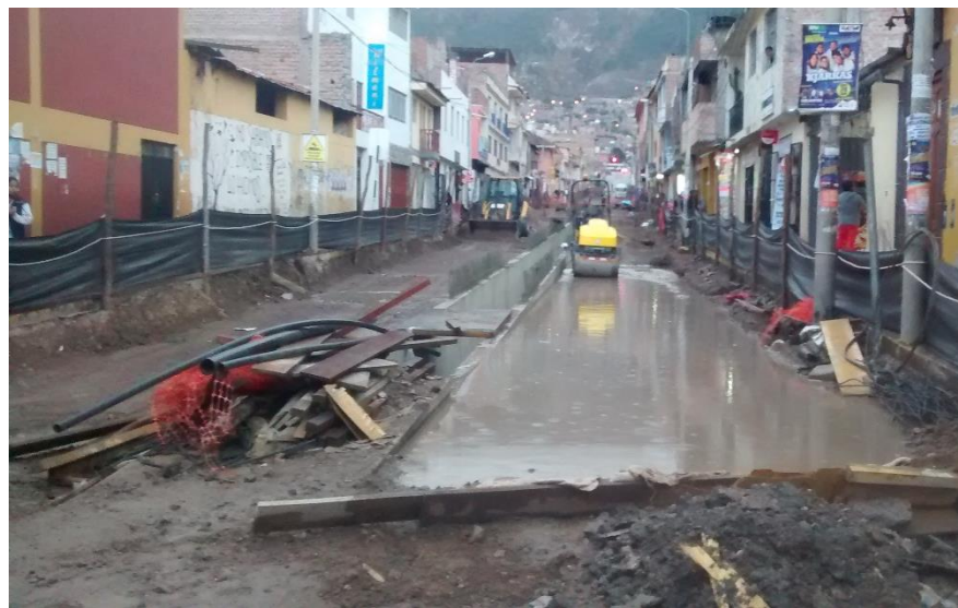
Figura 27. Tramo abandonado listo para encofrado de techo de canal. Jr. Manco Cápac.
