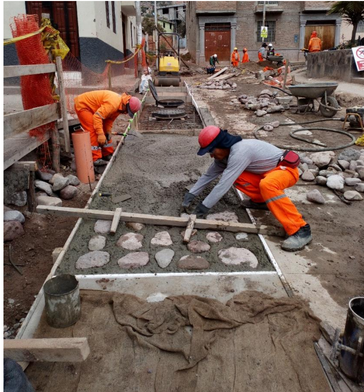
Foto 36. Trabajos de emboquillado.
