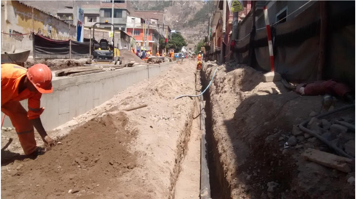
Foto 13. Instalación de nuevas redes de agua potable.
