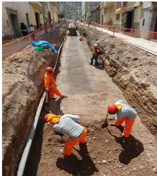
Figura 21. Tendido de geomalla y conformación de sub base granular L = 100 m. Jr. Callao cuadra 03.
