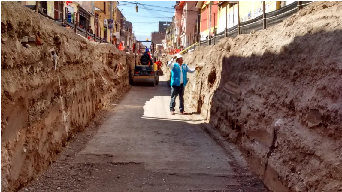
Foto 07. Conformación de base para canal de drenaje.
