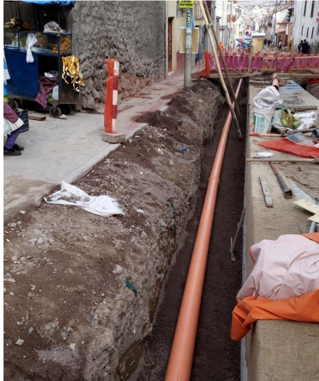
Foto 34. Instalación de redes de alcantarillado.
