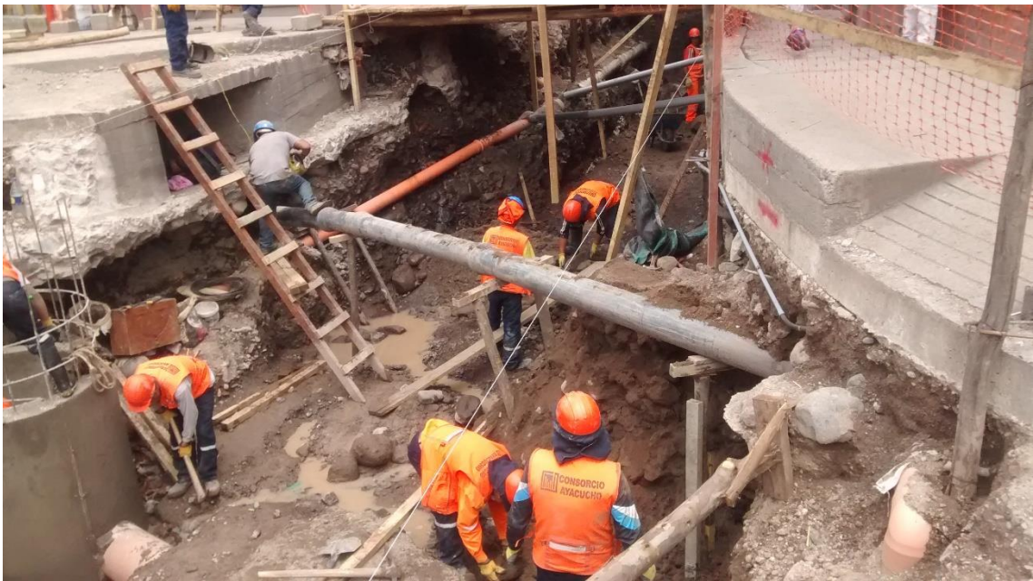
Foto 18. Perfilado de zanja para canal, se muestran interferencias encontradas.
