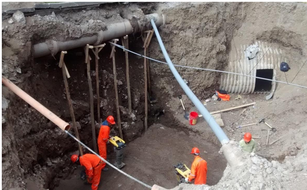
Figura 19. Trabajos de compactación. Jr. Quinua.
