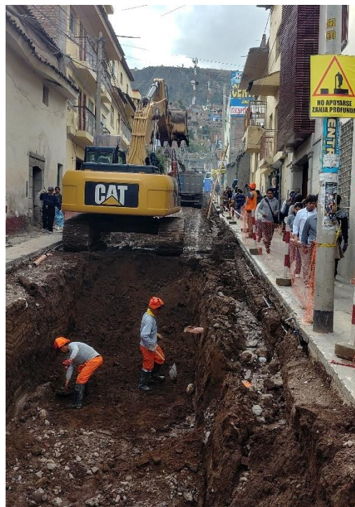
Foto 29. Inicio de excavación masiva.
