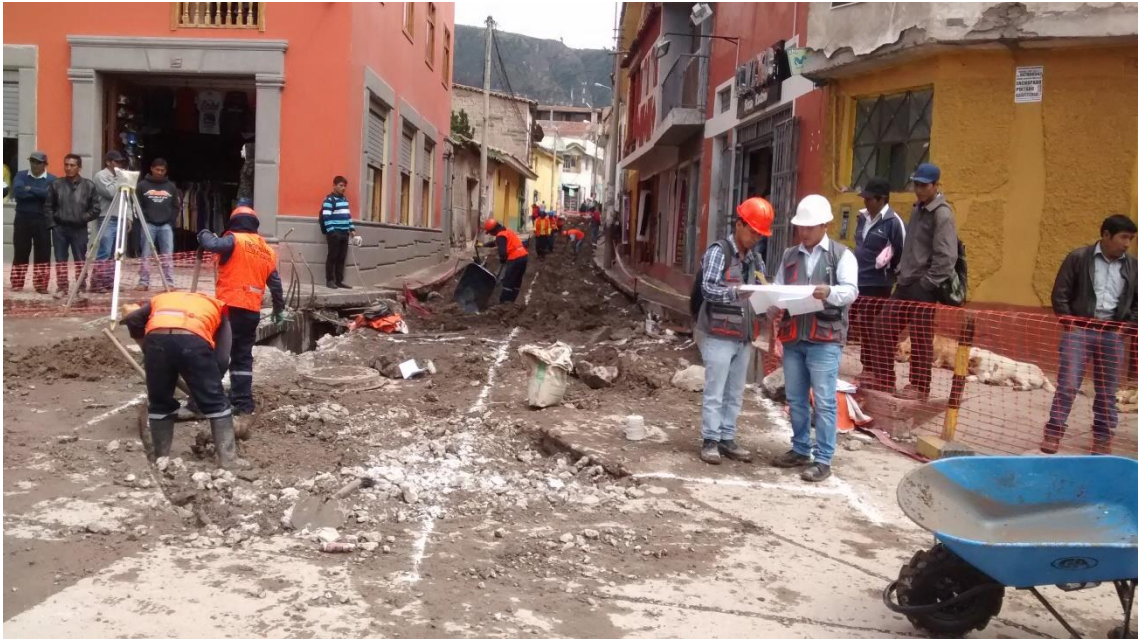
Foto 17. Trazo para excavación masiva.
