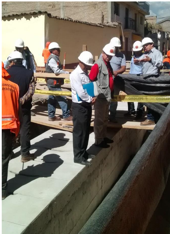
Foto 26. Inspección por supervisión de la MPH.
