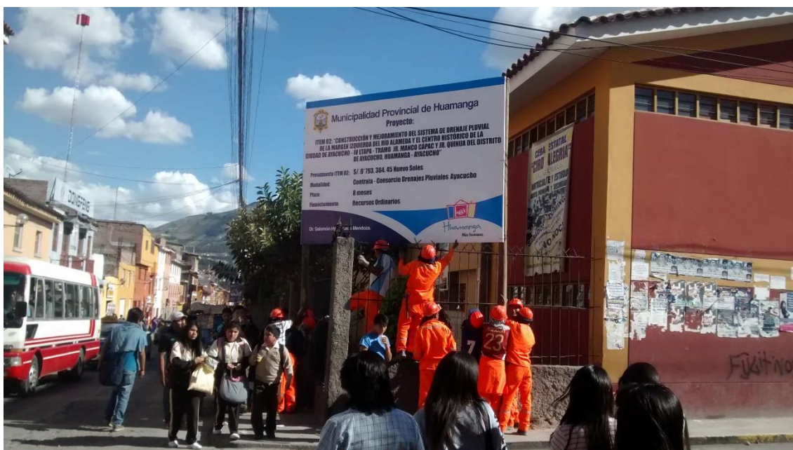
Foto 01. Instalación de cartel de obra.
