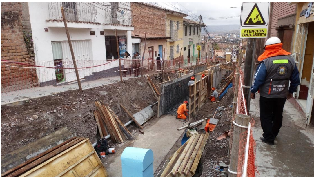
Figura 25. Trabajos de encofrado en canal de drenaje. Jr. Lima cuadra 03.
