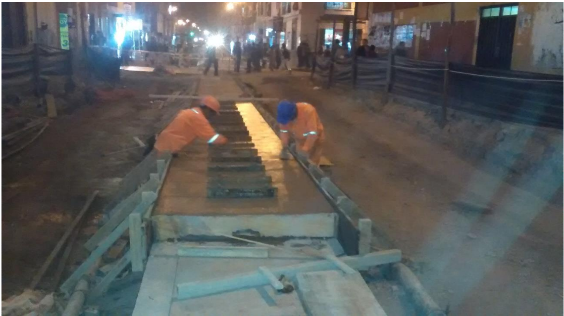
Foto 12. Vaciados de concreto nocturno.
