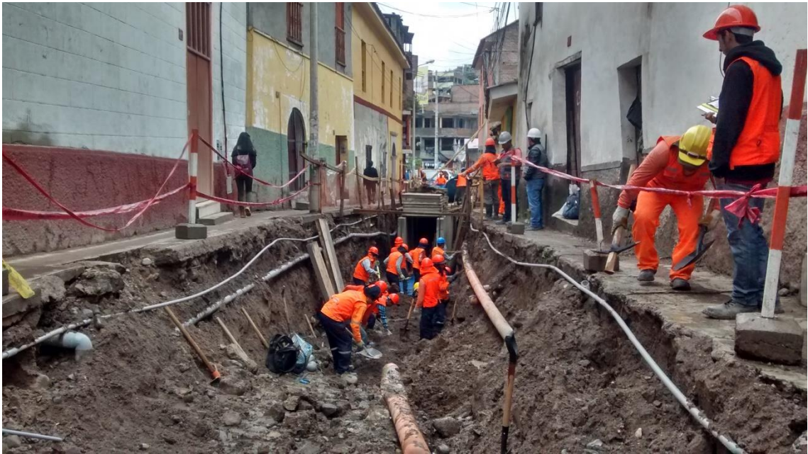
Foto 22. Limpieza de excavación para canal luego de lluvias torrenciales.
