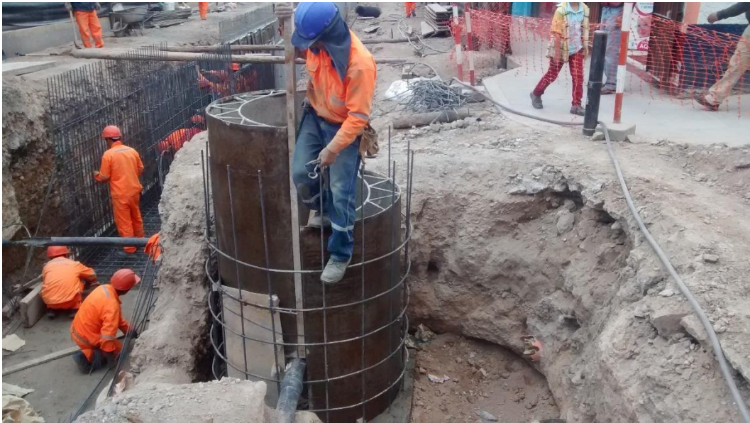
Foto 09. Instalación de acero en canal y buzones de alcantarillado.
