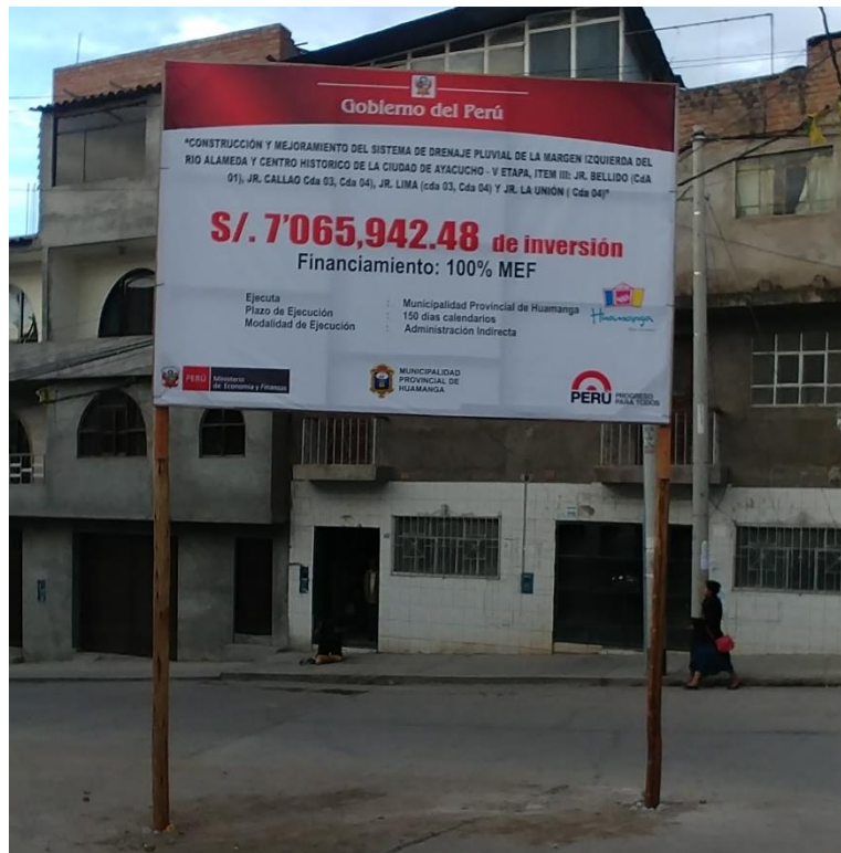
Foto 28. Cartel de obra del proyecto.
