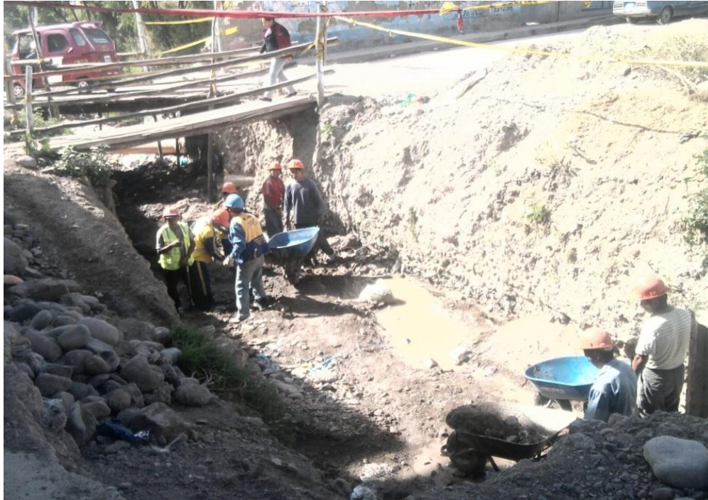
Figura 14. Limpieza de corte para canal de drenaje pluvial. Jr. San Martín cuadra 01. Fuente: Fotografía tomada del proyecto I ETAPA (2010)
