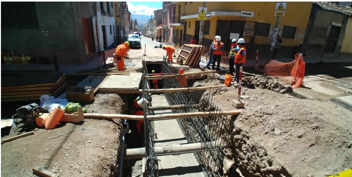
Foto 31. Trabajos en estructura de canal.
