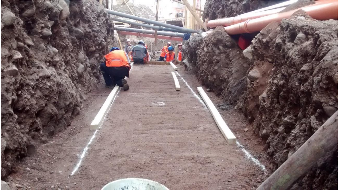
Foto 19. Conformación de base para canal.
