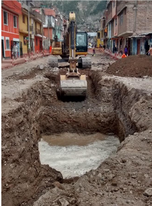
Foto 05. Excavación masiva y rotura de tuberías.
