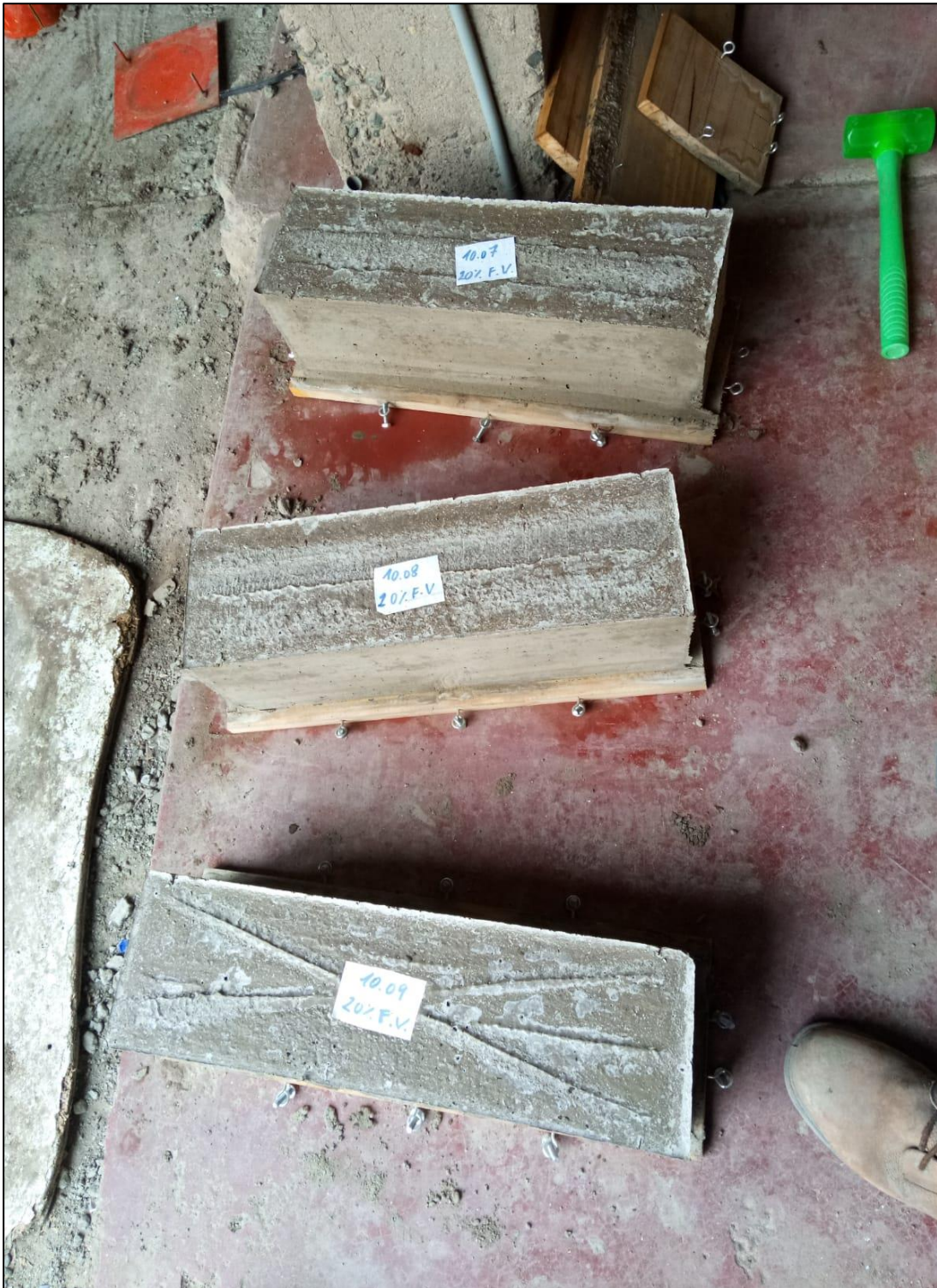
Figura N° 54: Desencofrado de Vigas
