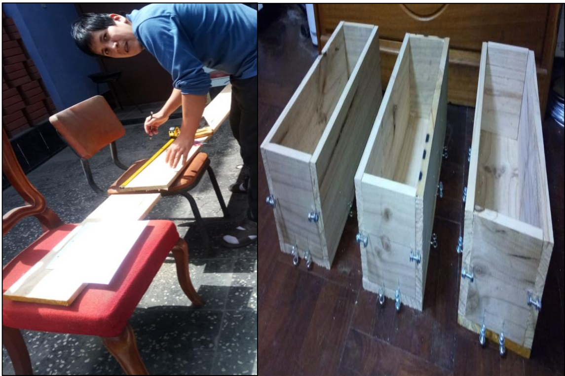
Figura N° 10: Moldes para Vigas
