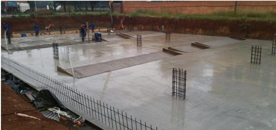
Figura 4: Platea de cimentación vaciada en obra
