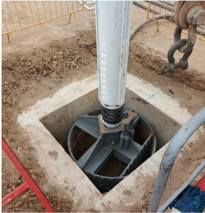
Figura 21: Inicio de excavación con balde cortador
