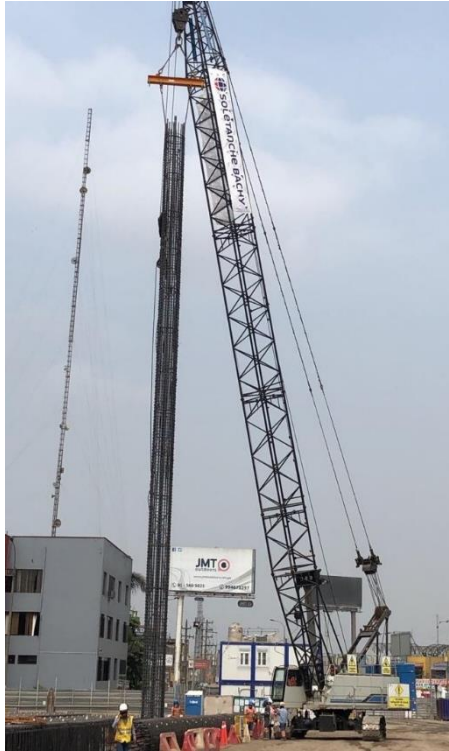
Figura 22: Izaje de armadura de refuerzo
