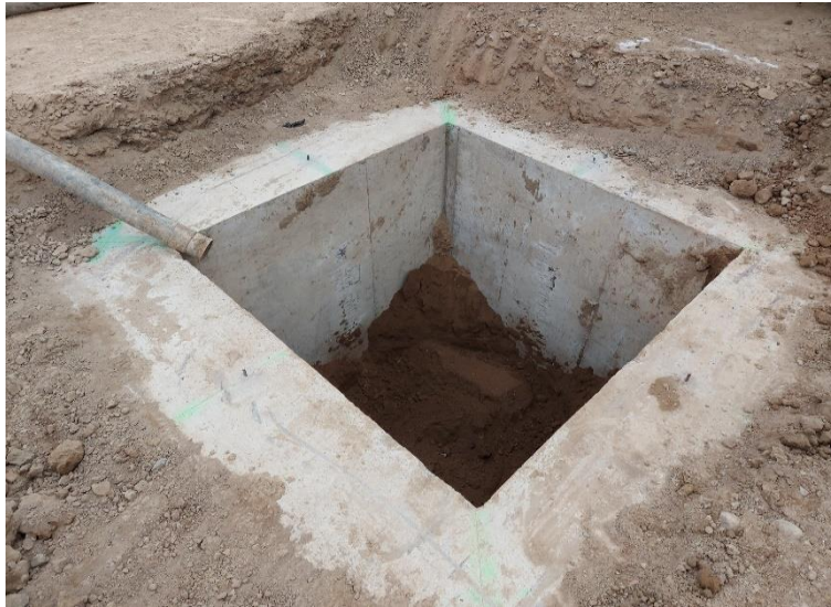
Figura 20: Muro guía Fuente: Elaboración propia
