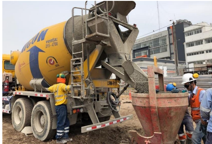
Figura 24: Vaciado de concreto
