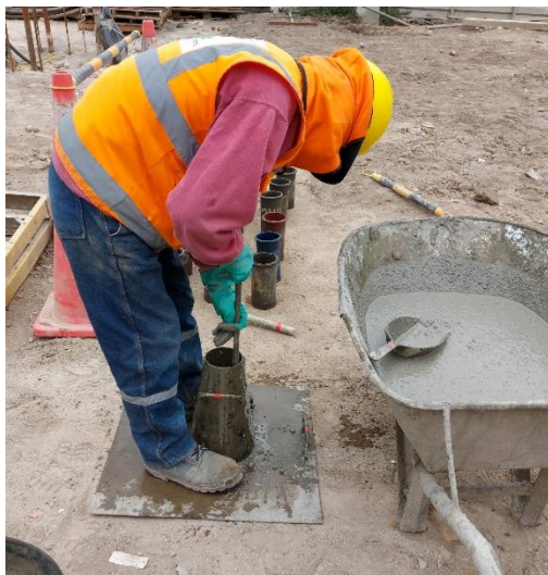
Figura 18: Ensayo de asentamiento
