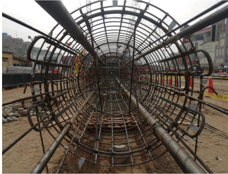
Figura 15: Armadura de refuerzo
