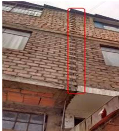
Figura: 27 Problema de junta sísmica
