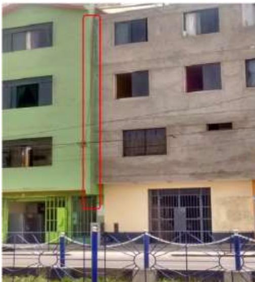
Figura: 26 Problema de junta sísmica
