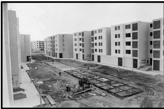
Foto Construcción del Complejo.
