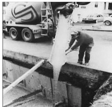
Figura N°31: Colocación de relleno fluido directamente del mixer
