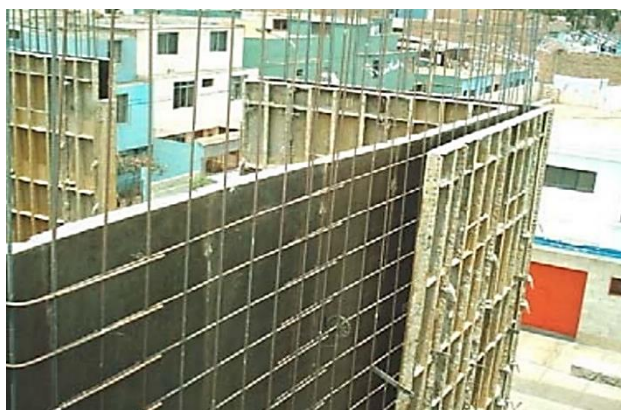
Figura N°40: Malla y encofrado en EMDL
