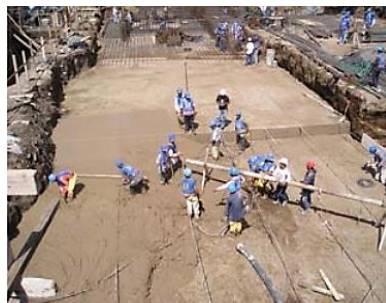
Figura N°34: Aplicación del relleno fluido en rellenos estructurales
