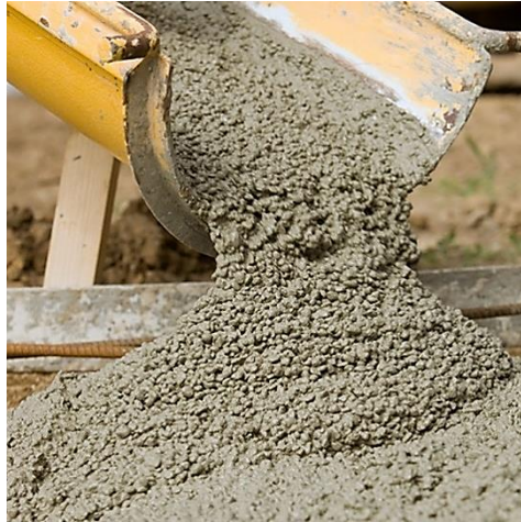
Figura N°30: Relleno fluido en estado fresco
