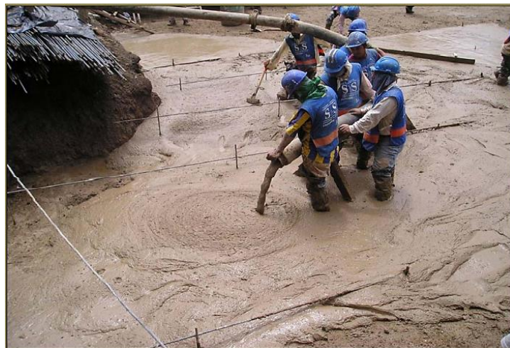
Figura N°29: Bombeo de relleno fluido para mejoramiento del suelo
