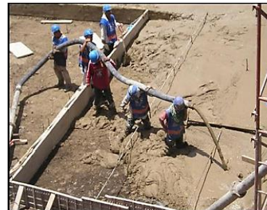
Figura N°34: Aplicación del relleno fluido en rellenos estructurales
