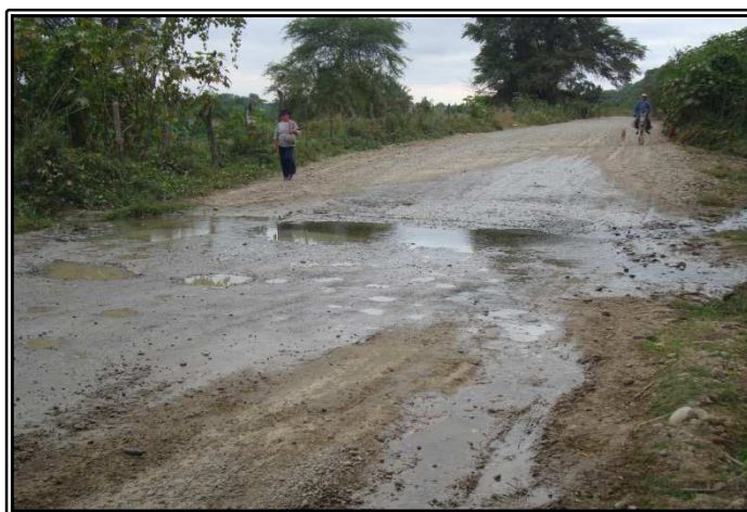
Figura N° 2: Badén en progresiva 10+000
