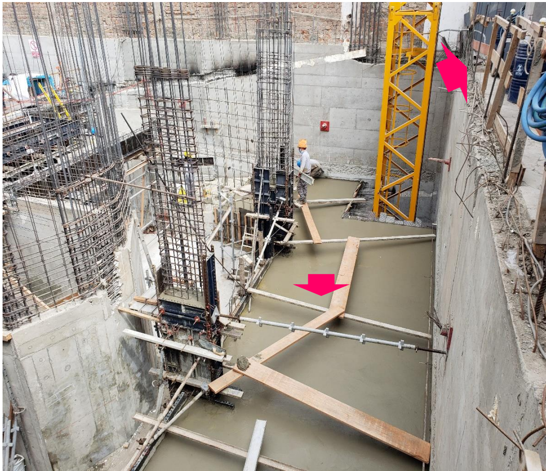
Figura 36. Empleo de madera durante la construcción del edificio multifamiliar Siena Fuente: Imagen obtenida de la obra Edificio Multifamiliar Siena de Inmobiliaria Los Fresnos S.A.C., 2020.
