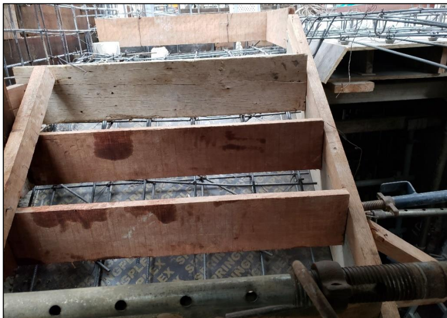
Figura 38. Uso de madera para encofrado de escalera
