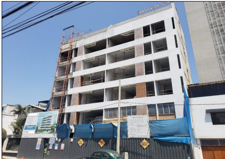
Figura 91. Condición climática en el distrito de Magdalena, lugar de ejecución del Edificio Multifamiliar
