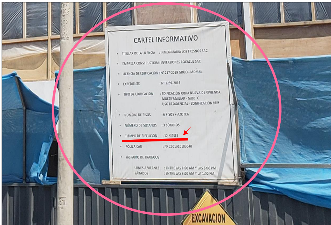
Figura 98. Presupuesto inicial de obra: Proyecto Multifamiliar en el distrito de Magdalena Fuente: Imagen tomada de obra Edificio Multifamiliar Siena de Inmobiliaria Los Fresnos S.A.C., 2020.
