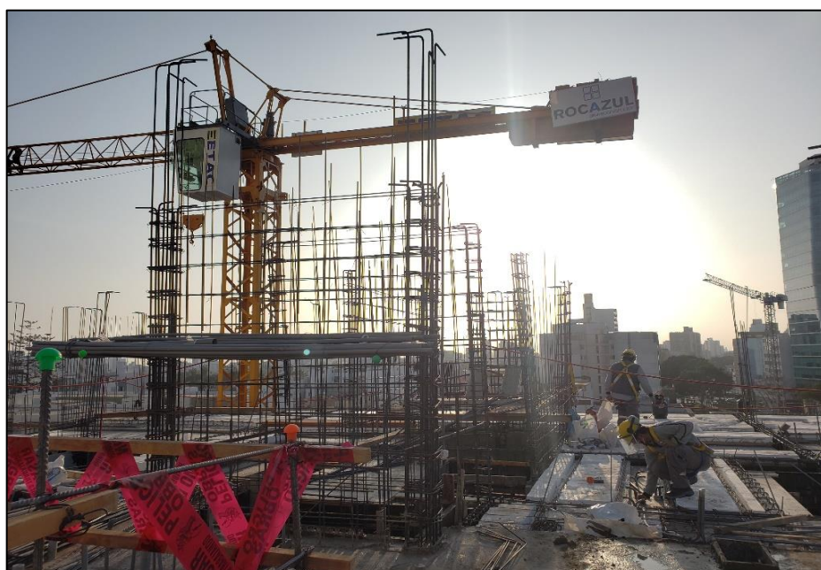
Figura 41. Consumo de energía eléctrica para el funcionamiento de la grúa torre. Fuente: Imagen obtenida de la obra Edificio Multifamiliar Siena de Inmobiliaria Los Fresnos S.A.C., 2020.
