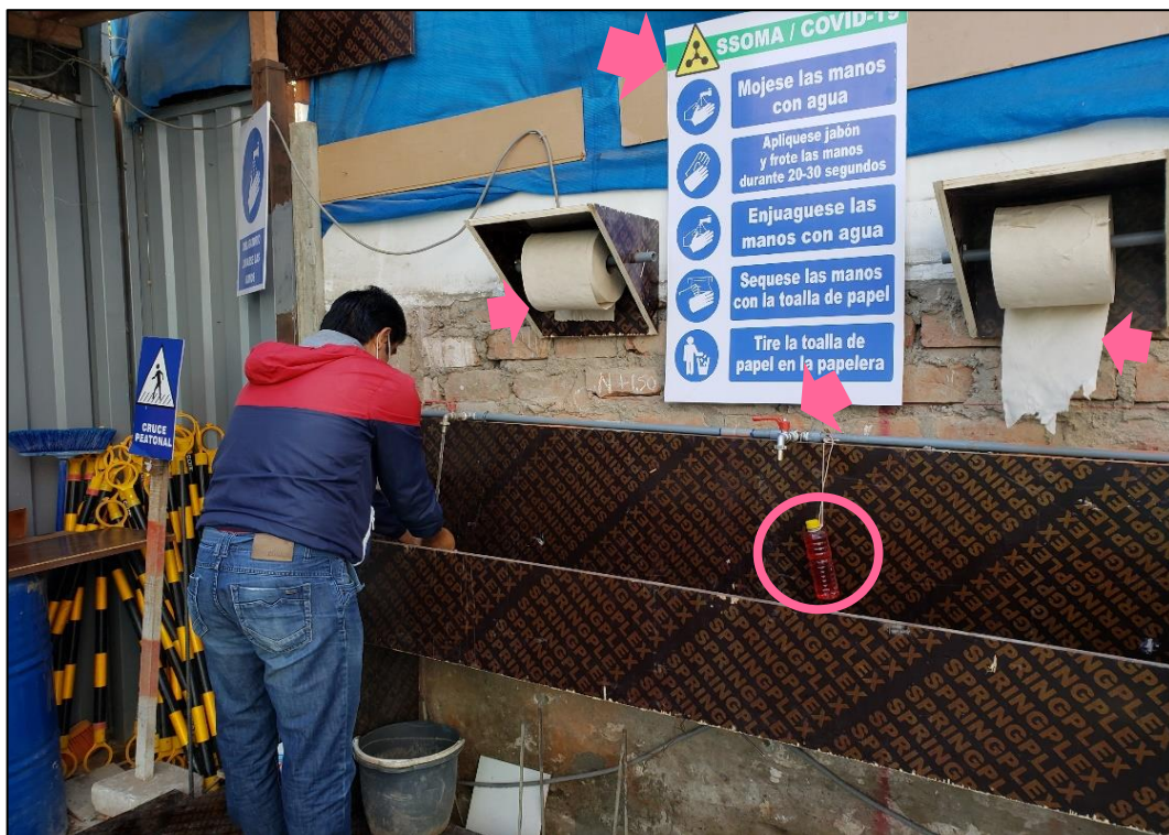
Figura 106. Lavaderos para desinfección de manos en el ingreso a las instalaciones de la obra.
