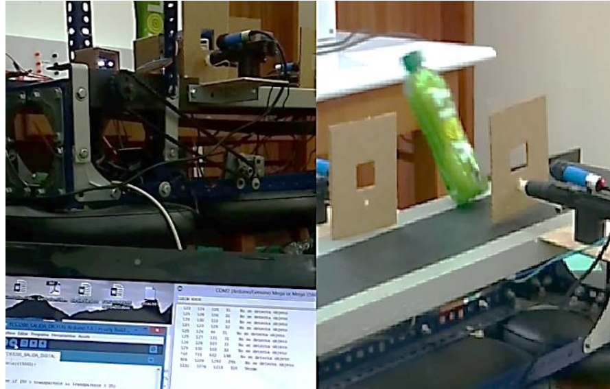
Figura 89: Detección del sensor y accionamiento del actuador con el color verde
