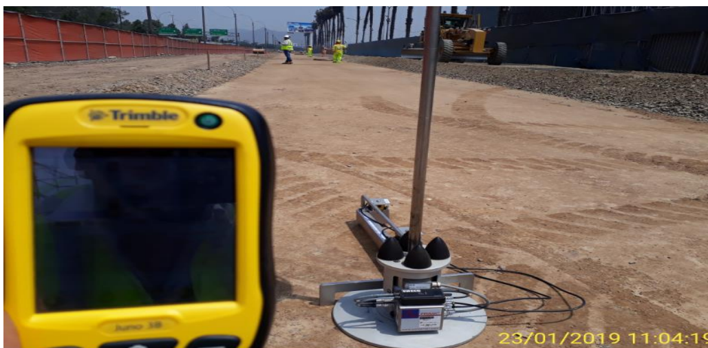
Figura 27: Ensayo en campo con el equipo Light Falling Weight Deflectometer en una capa conformada. Fuente: Elaboración propia.
