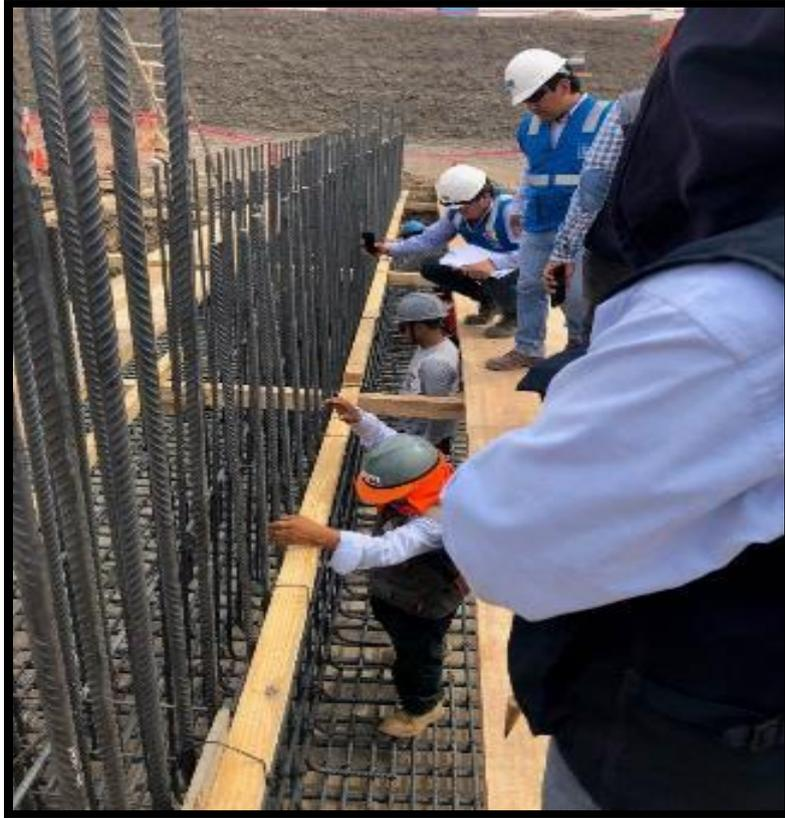
Figura 66: Colocación de acero en Cimentación
