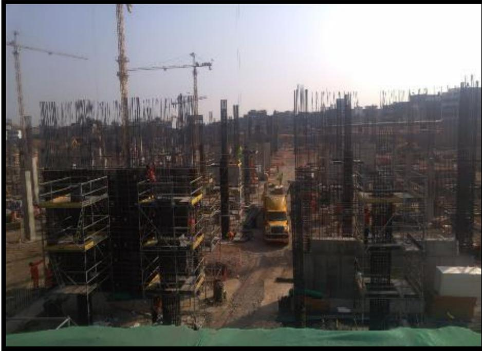
Figura 74: Colocación de acero y encofrado en elementos verticales
