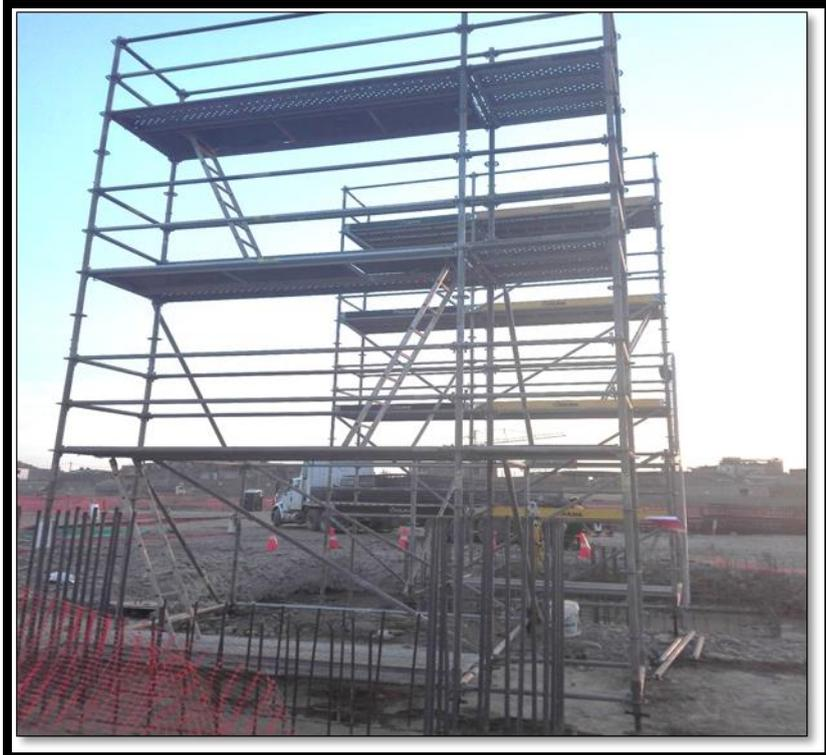
Figura 70 : Colocación de andamios para montaje de acero en verticales
