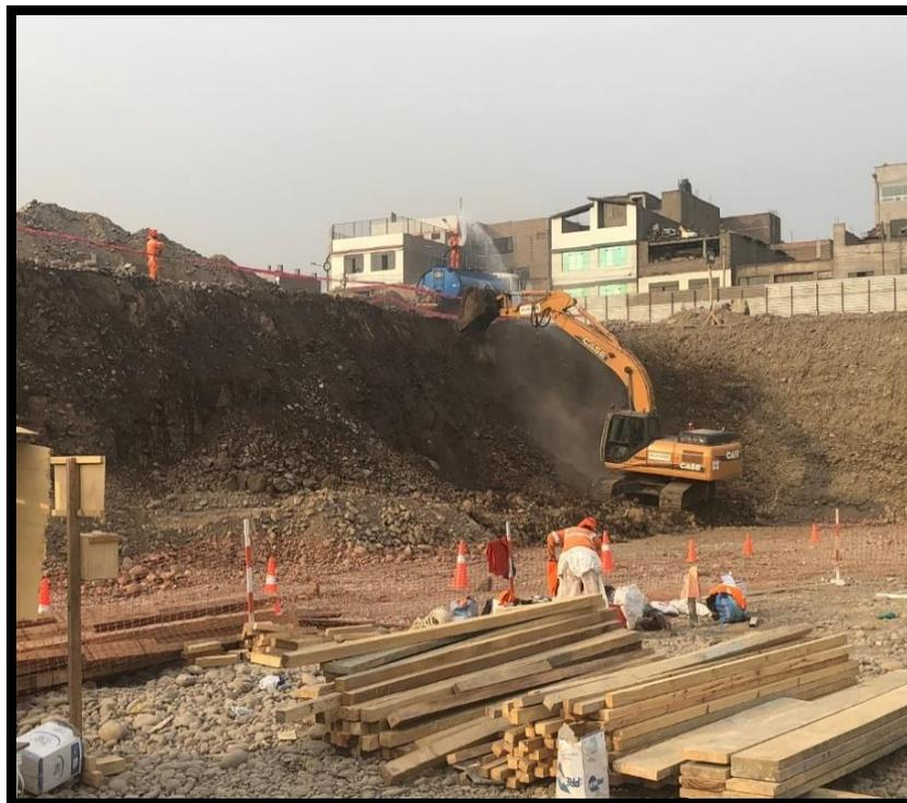
Figura 69: Corte masivo y excavación de cimentación
