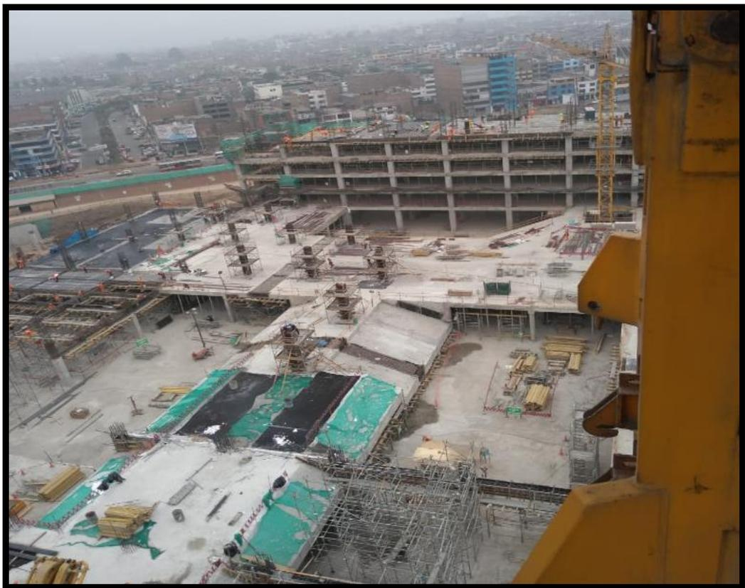
Figura 81: Avance con el encofrado horizontal niv. + 11.50
