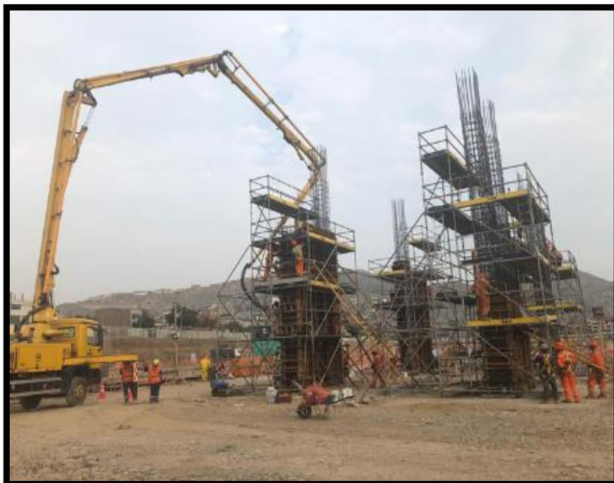
Figura 71: Inicio de encofrado y vaciado de elementos verticales
