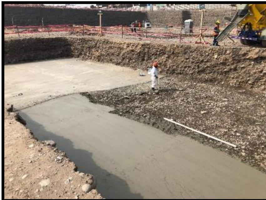
Figura 65: Vaciado de solados de zapata
