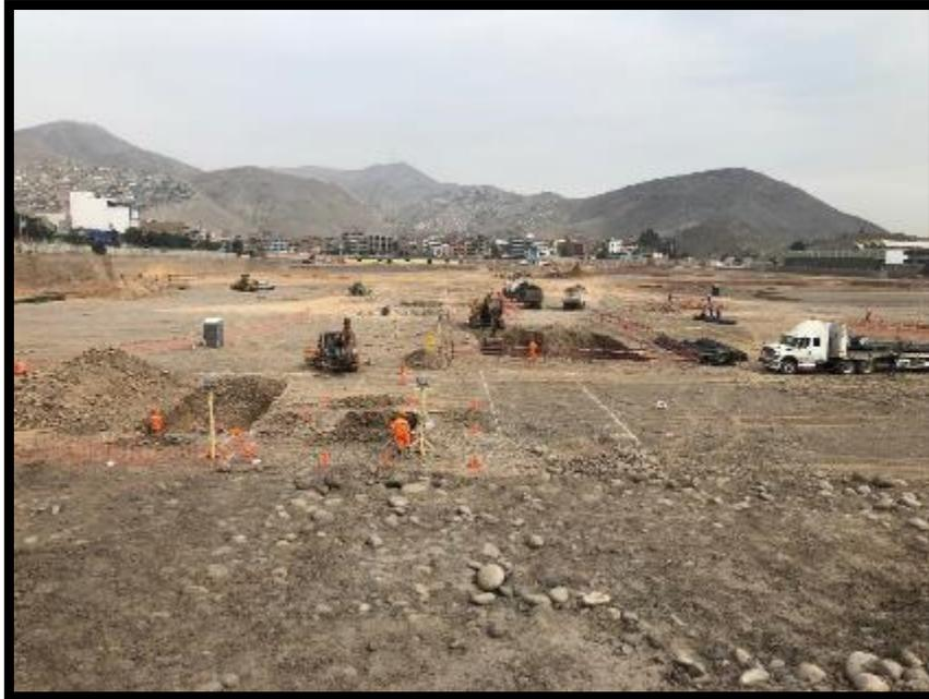
Figura 64: Trazo, replanteo y excavación
