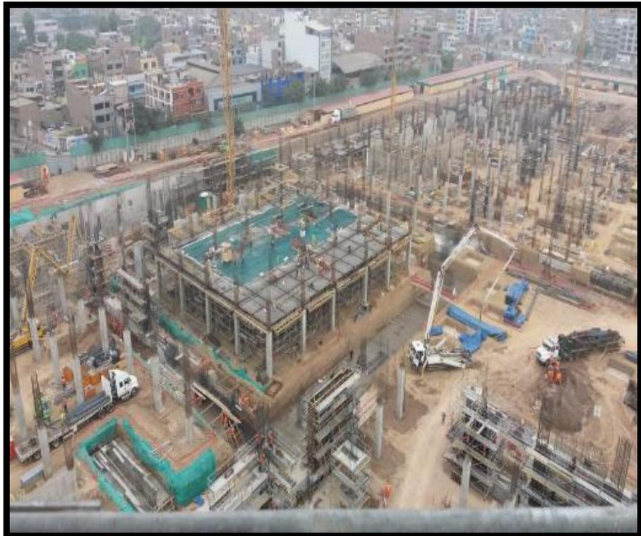
Figura 77: Vaciado y curado de losa
