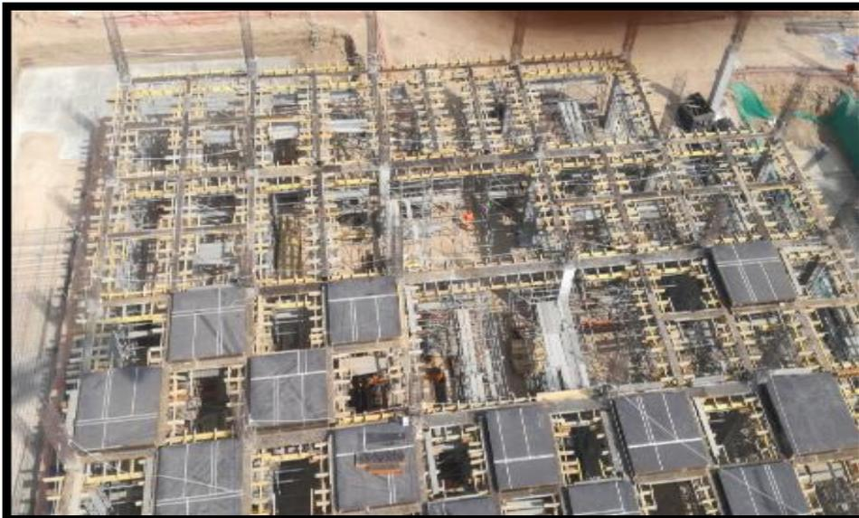
Figura 75: Encofrado de Elementos Horizontales
