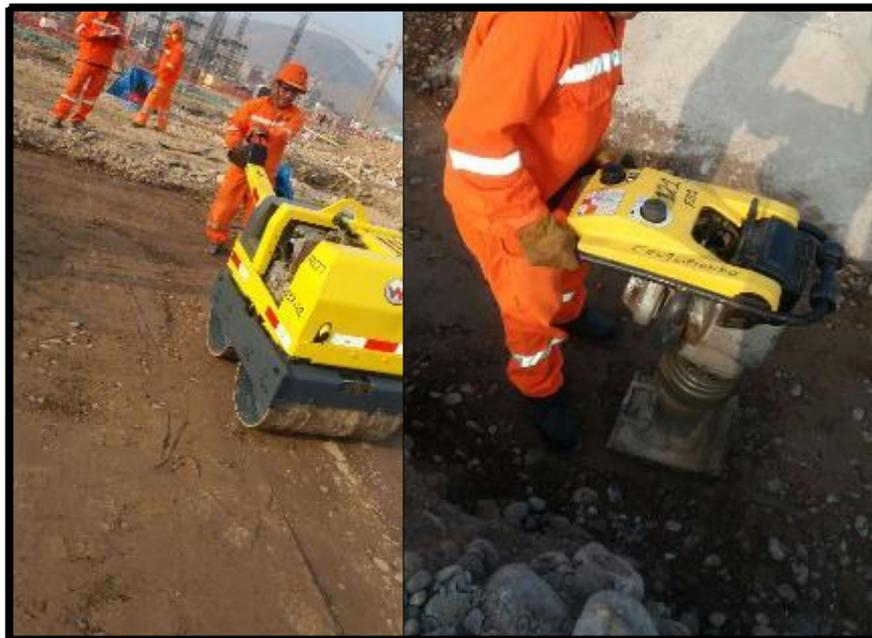
Figura 73 : Relleno y compactación con material propio
