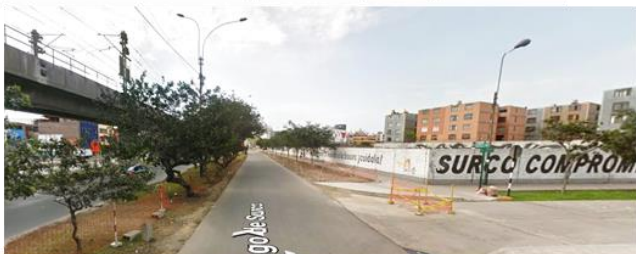
4 Vista – Esquina del terreno
