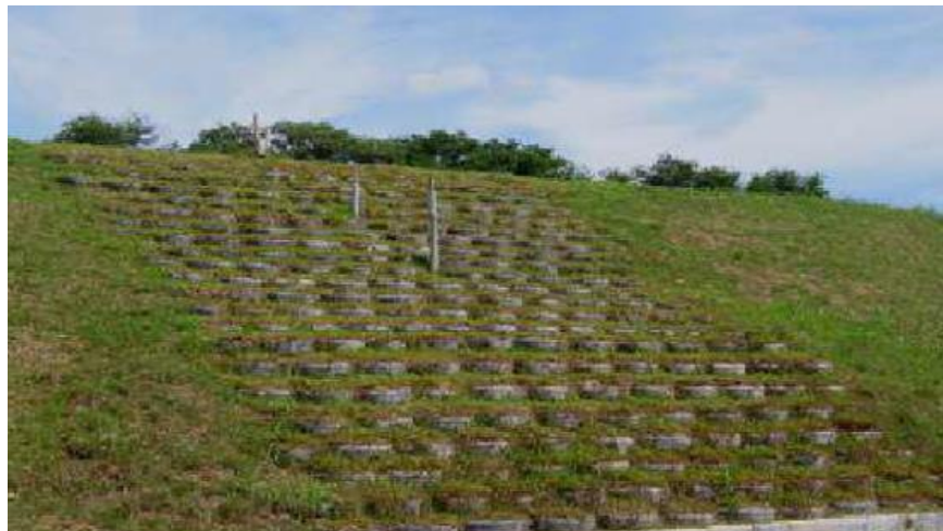
Figura 9: Vista general de una obra desarrollada con llantas de refuerzo Fuente: Rodríguez (2016)
