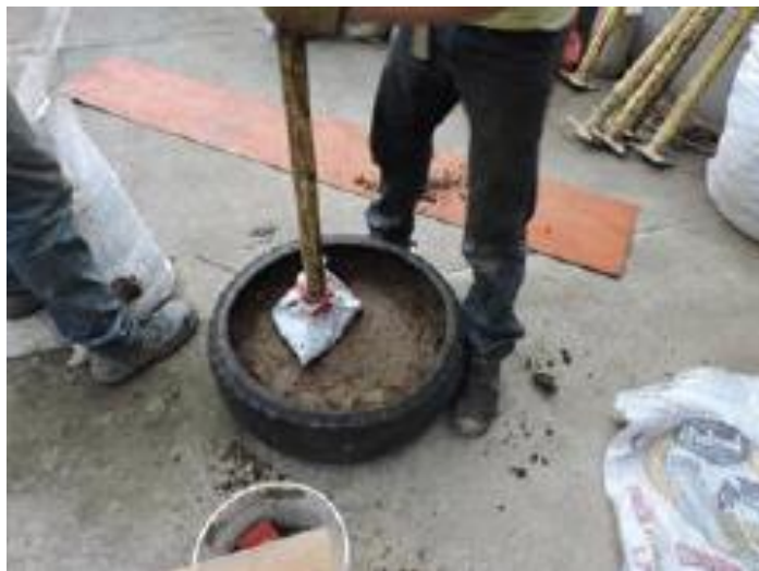
Figura 13: Llenado manual de material seleccionado en la llanta
