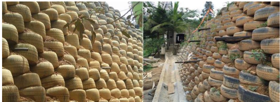
Figura 15: Sistema de drenaje para muros de llantas
