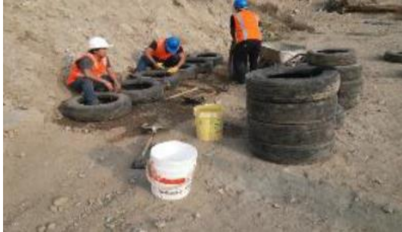
Figura 10: Conformación y nivelación del terreno
