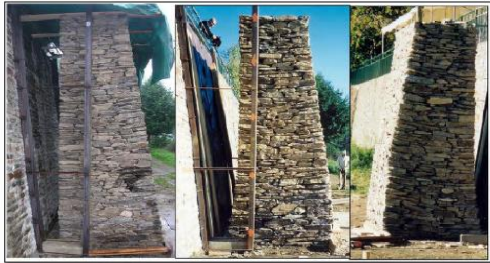
Figura 16: Muro de pircas
