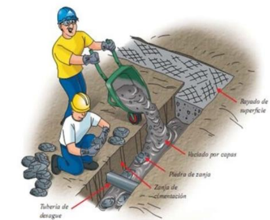
Figura 18: Aplicación del solado
