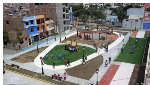
Remodelación del Parque Santa Rosa, urbanización Monserrate I Etapa
