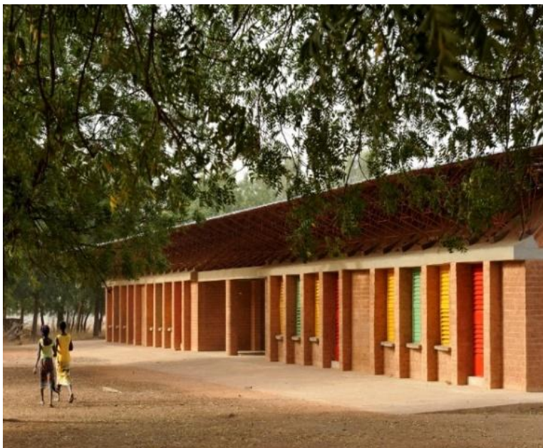
Foto N.07: Pabellón de la Escuela Primaria Gando
