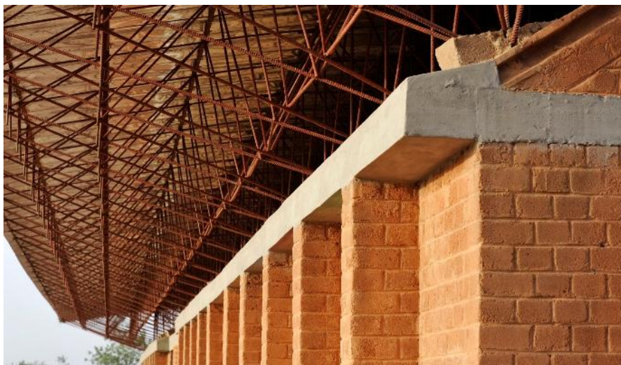
Foto N.06: Pabellón de la Escuela Primaria Gando
