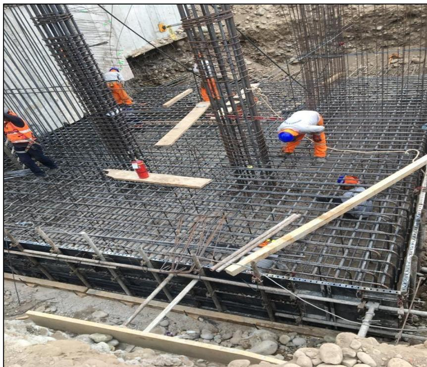
Nota. Habilitado y colocado de acero en zapatas y columnas, previo a la actividad de vaciado. Elaboración propia.
