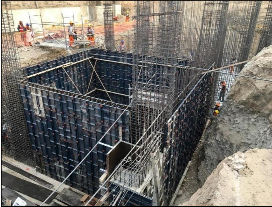
Nota. Se observa las columnas y placas prefabricadas, y su optimización en los tiempos de ejecución, puesto que los dichos elementos sobrepasan el vaciado programado (nivel de encofrado), lo cual facilitaría la rapidez para el encofrado del siguiente nivel. Elaboración propia.
