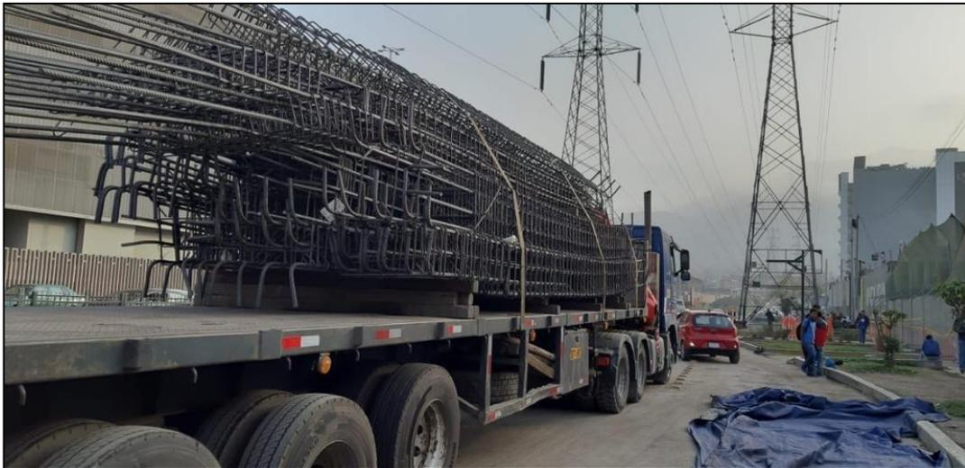
Nota. Como se puede apreciar en la imagen, los elementos estructurales como el prefabricado llegan a obra para su posterior izaje y colocación. Es evidente que la gran producción de elementos reducirá la mano de obra y el tiempo en el habilitado de acero. Elaboración propia.
