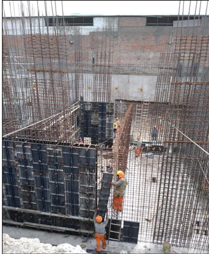
Nota. Actividades de encofrado en muros de corte o placa, previo a la actividad de vaciado. Elaboración propia.
