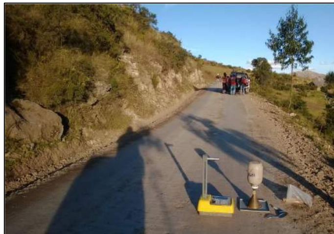
Figura 4.29 – Control de humedad y densidad
