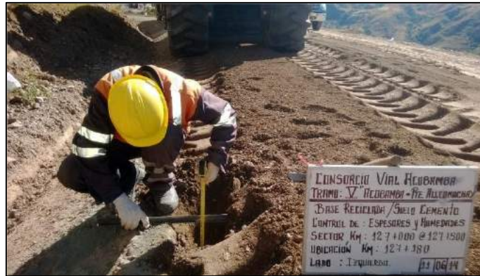
Figura 4.28 – Control de espesor de capa reciclada
