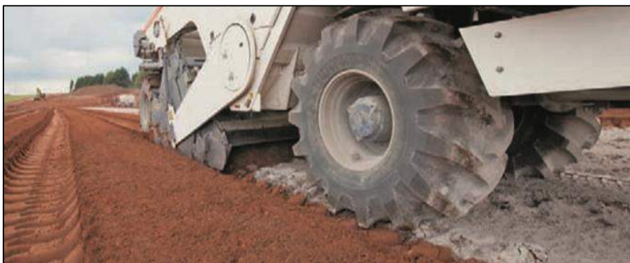
Figura 4.9 – Base reciclada suelo – cemento
