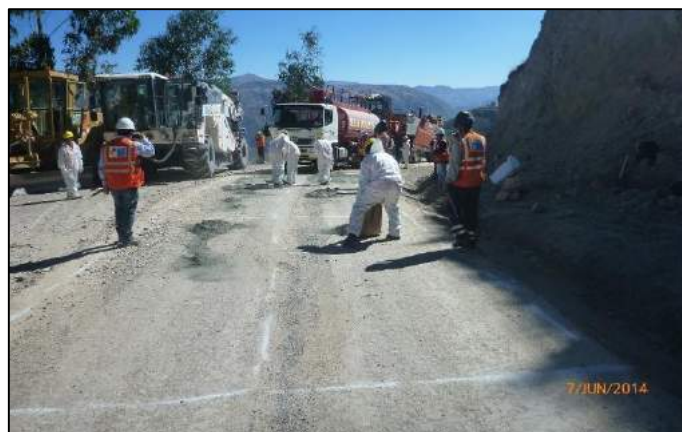
Figura 4.23 – Grilla para colocación de cemento Fuente: Cabello – Limonchi 2014
