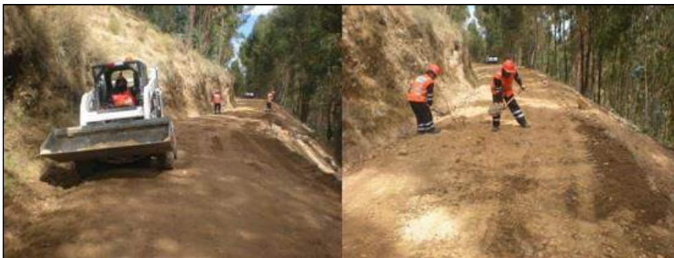
Figura 2.9 – Trabajos de mantenimiento rutinario antes
