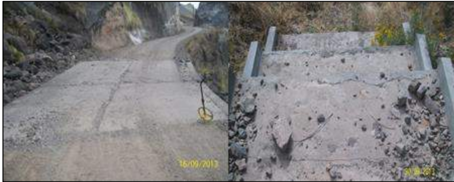
Figura 4.5 – Evaluación de obras de arte existentes
