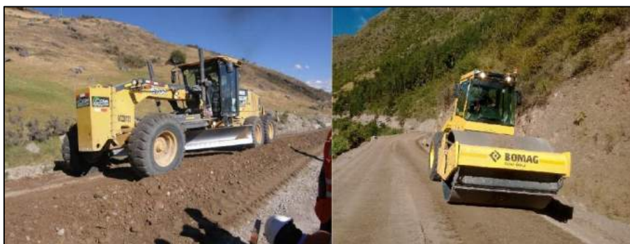
Figura 4.27 – Perfilado y compactación
