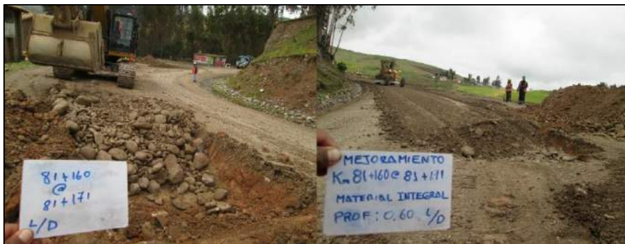
Figura 4.36 – Mejoramiento de terreno de fundación
