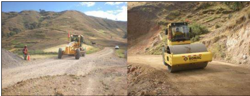
Figura 2.8 – Trabajos de transitabilidad
