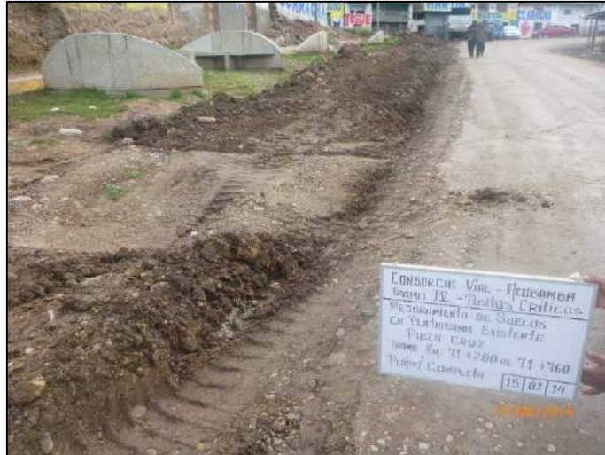
Figura 4.3 – Mejoramiento de Terreno de fundación Fuente: Consorcio Vial Acobamba – 2014
