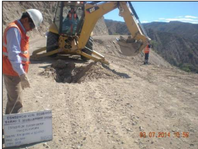
Figura 4.1 – Evaluación del pavimento existente por medio de calicatas
