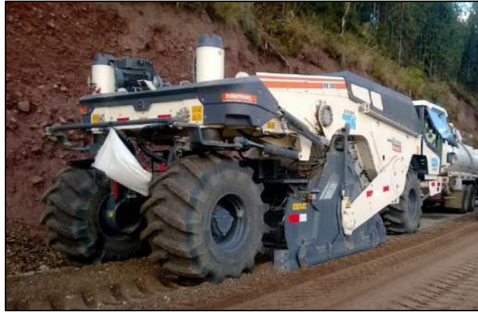
Figura 4.25 – Proceso de reciclado Base suelo – cemento
