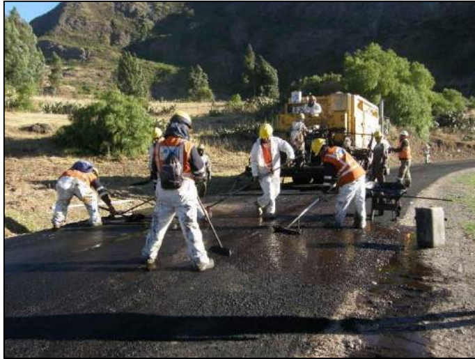
Figura 4.33 – Colocación de micropavimento
