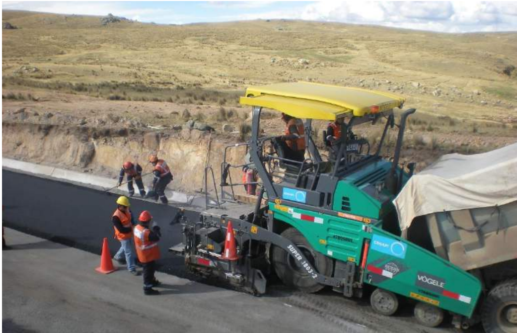
Figura 3.3 – Colocación de MAC
