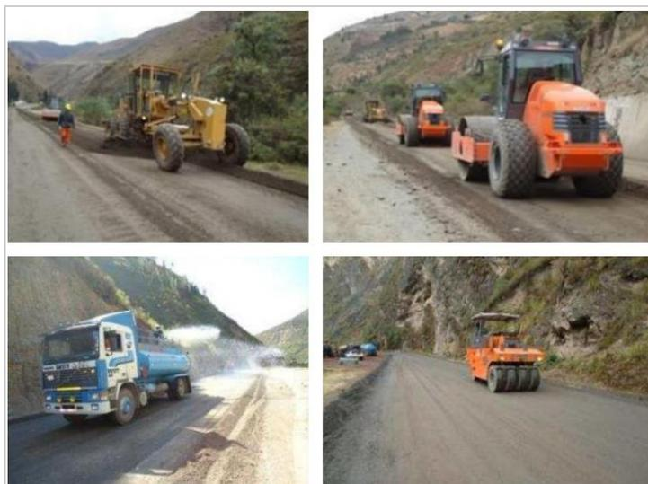
*Nota:* en la imagen se aprecian las maquinarias empleadas en el proceso de compactación de la carpeta asfáltica reciclada con asfalto espumado. Estas maquinarias se componen de una motoniveladora, dos rodillos lisos, una cisterna de agua y un rodillo neumático. Extraído de Espinoza et al. (2014).
