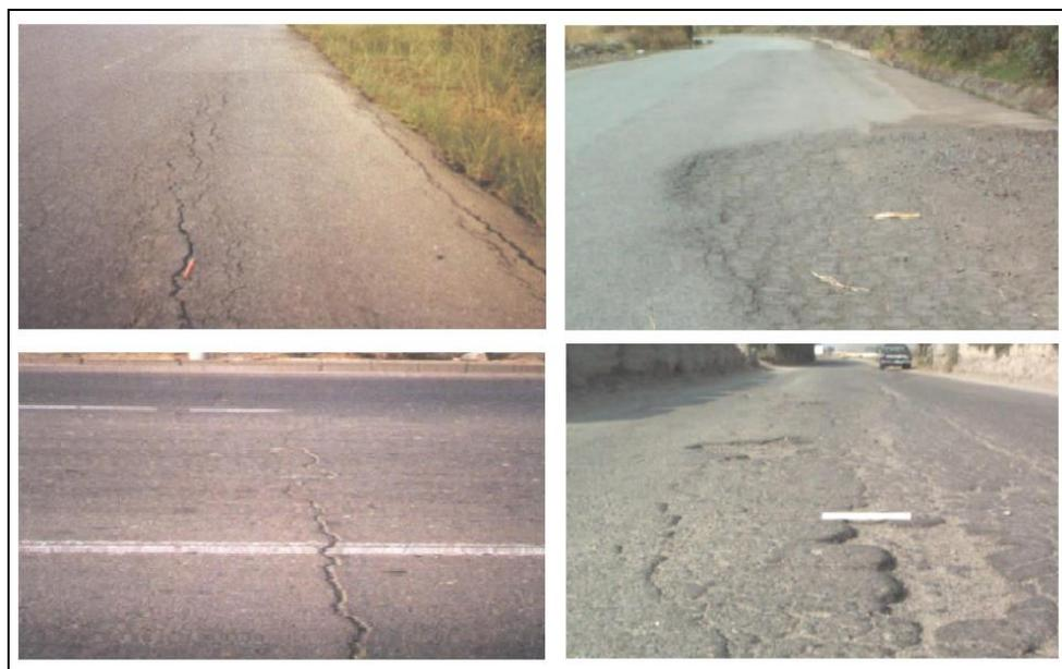
*Nota:* las imágenes de las fallas del pavimento has sido extraída del manual de carreteras, mantenimiento o conservación vial y muestran baches, grietas longitudinales y transversales y hundimiento en el pavimento. (MTC, 2016)
