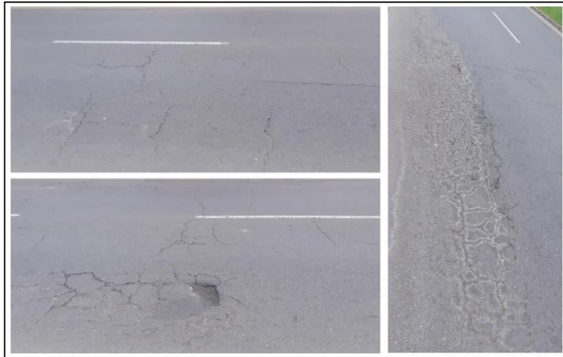
Nota: la figura muestra el fisuramiento tipo piel de cocodrilo en diversas etapas. En su inicio, las fisuras se encuentran relativamente distantes unas de otras. A medida que avanza el deterioro las grietas se abren e incluso se puede generar que se desprendan porciones de pavimento por la acción del tráfico. Elaboración propia.
