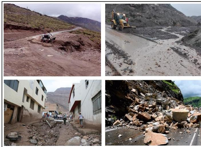
Nota: la figura muestra una serie de vías que se han visto afectadas a causa de derrumbes como son los huaicos y una mala estabilidad en los taludes de los cerros. Adaptación propia.
