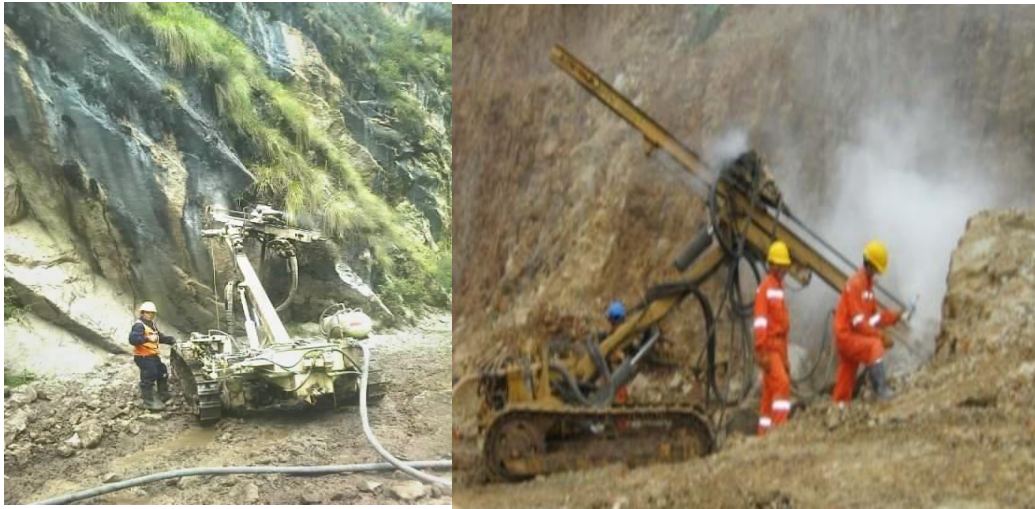
Figura N° 14: Equipos de perforación hidráulica (Track drill)
