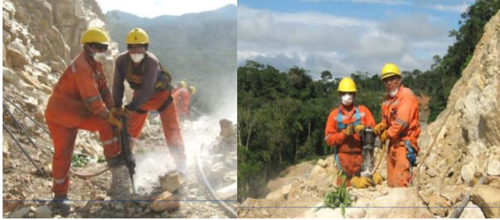
Figura N° 13: Equipos de perforación manual
