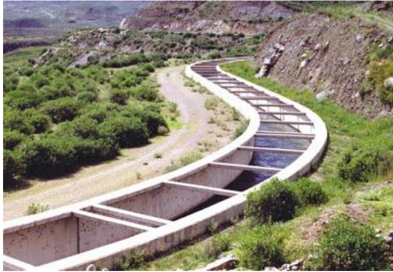
Ilustración N° 43: Canal de Aducción
