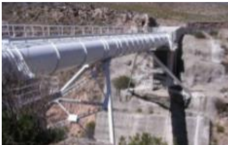
Ilustración N° 42: Acueducto de acero en Quebrada Matadero
