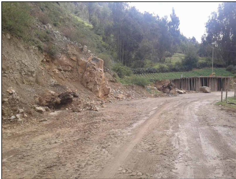
Figura N°34: Carretera de tierra, Ingenio
