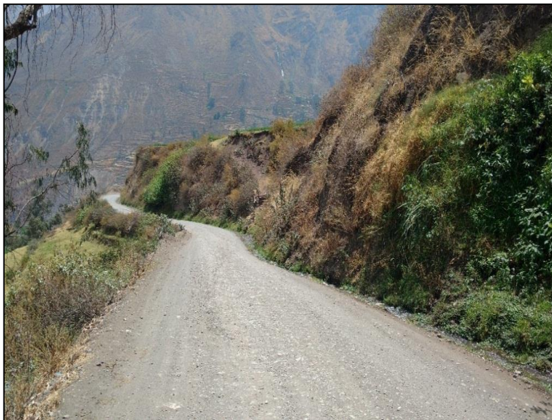
Figura N°36: Carretera afirmada, Canta
