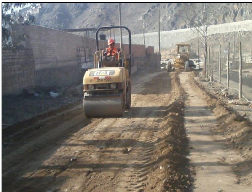
Figura N°46: Compactación de un camino de afirmado
