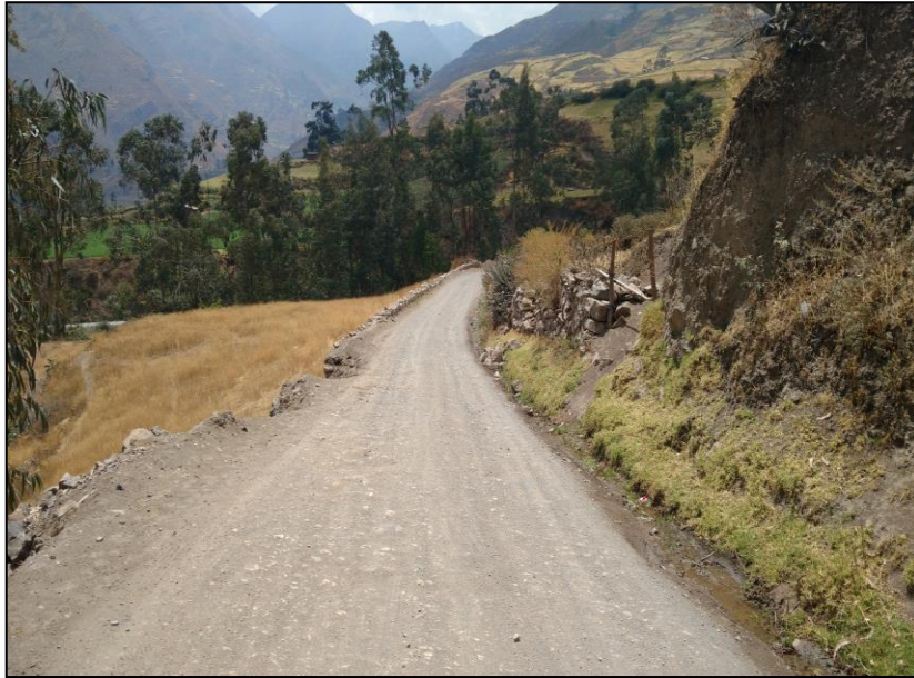
Figura N°35: Carretera afirmada, Obrajillo
