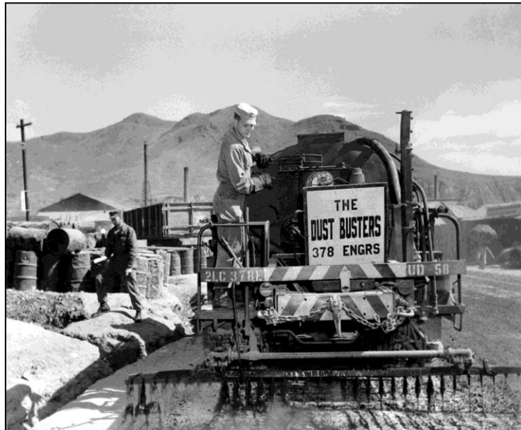
Figura N°30: Ingeniero rociando el polvo en la nueva carretera durante la Guerra de Corea
