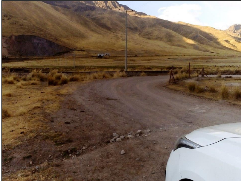
Figura N°33: Carretera de tierra, Occobamba
