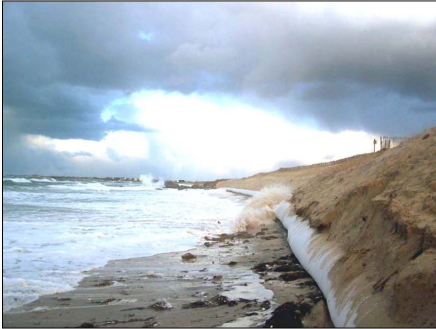
Photo 2. Effet réfléchissant du Stabiplage® et affouillement du haut de plage + bas de dune par le jet de rive (20/03/07 à 19h00, marée haute coefficient 116)
