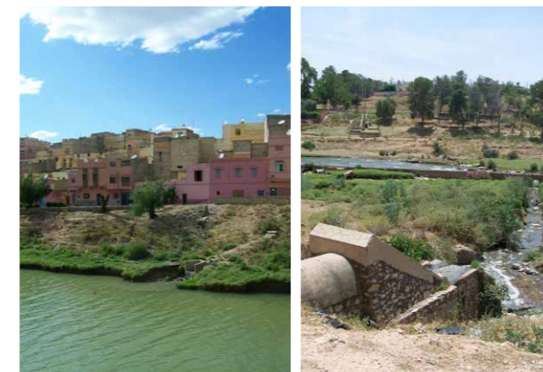
Rejets d'eaux usées domestiques directement dans l'oued Oum er Rbia à Kasba Tadla
