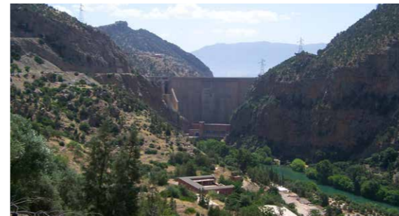
Barrage de Bin El Ouidane dans la vallée de l'oued El Abid
