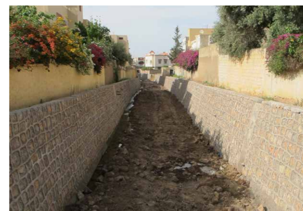
Aménagement de l'oued El Handak
