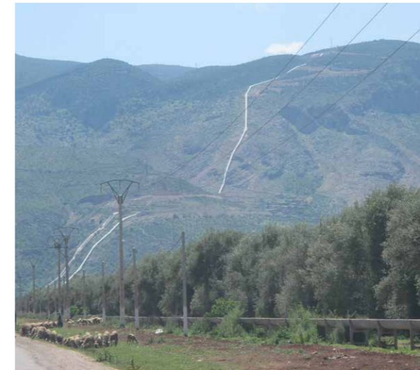
Conduite forcée d'Afourer
