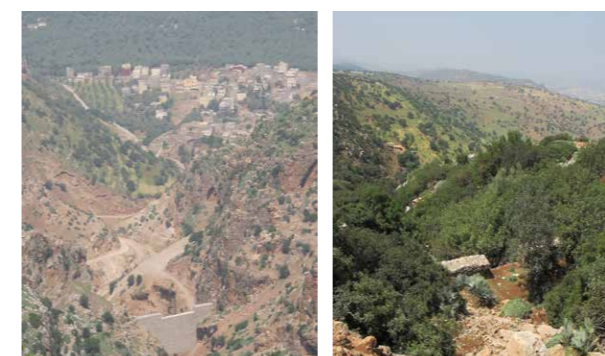
Aménagement de gabions et barrages collinaires écreteurs de crues dans l'oued pour protéger les zones urbaines en aval
