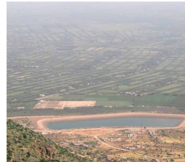
Bassin de stockage avant distribution des eaux vers le périmètre irrigué des Beni Moussa par un réseau de canaux
