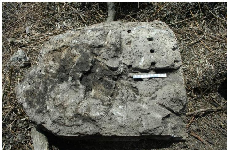
*Fig. 5. Frammento di geison in travertino con tracce di intonaco e mutuli saldati con il piombo.*
