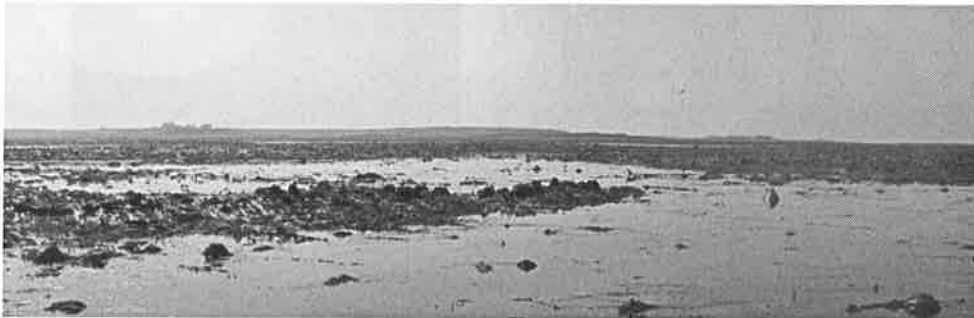
Figure 9 - Vue générale du barrage de pêcherie 'Gored Ar Chlo-1' vers le sud-ouest (cliché H. Gandois).
