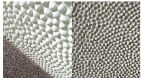
Gambar 6. Kiri: Aplikasi batu koral pada dinding, Kanan: Batu koral disusun acak. (Sumber: Dokumen Pribadi, 2021)
