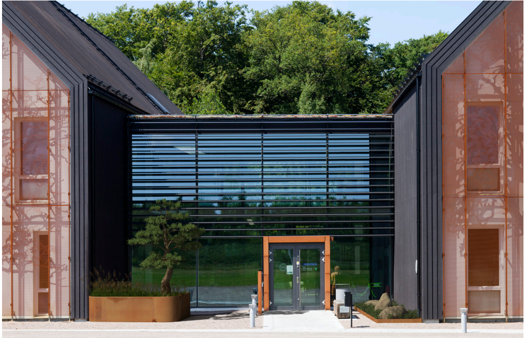
Regnbäddar som mottar dagvatten från tak via stuprör. Till vänster en upphöjd regnbädd och till höger en nedsänkt. Fotomontage: Tengbomgruppen.
