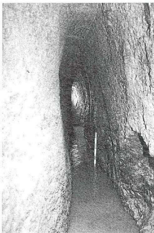
FIG. 20 - La galerie d'écoulement des eaux ou « Erbstoll » de la Fontaine des Chouettes.
