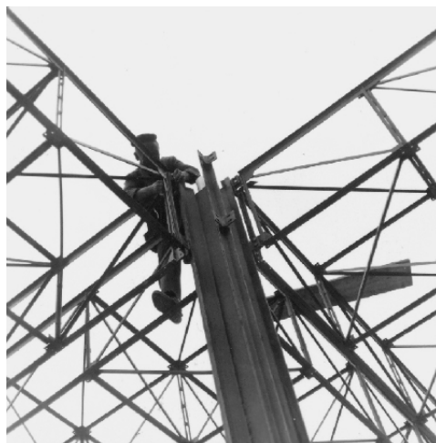
Edificio industriale a Longarone, 1965. Dettaglio del pilastro in acciaio, vuoto all'interno e accessibile, costituito da quattro profili in lamiera d'acciaio piegata e quattro angolari di serie; fotografia di cantiere.
