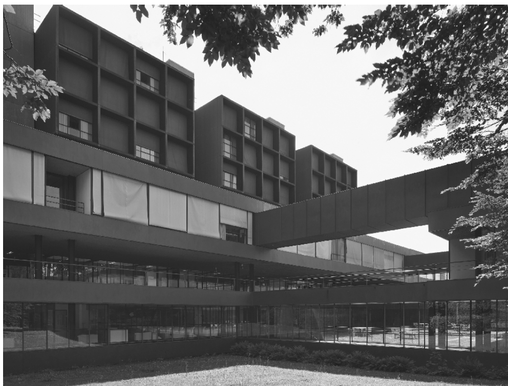
Centro Istruzione IBM a Novedrate, fotografie del complesso e, nella pagina a fianco, planimetria generale e schema assonometrico del sistema di assemblaggio
