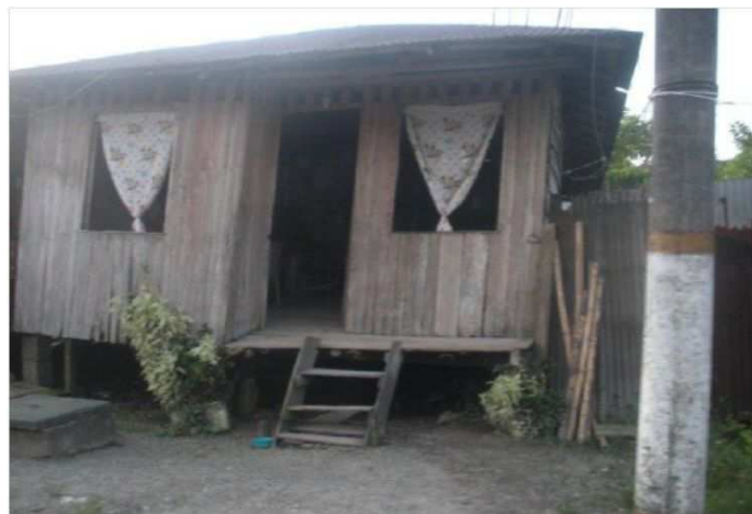
Figura 18. Construcciones típicas del municipio a nivel rural. Fuente:(González & Vargas, 2011)
