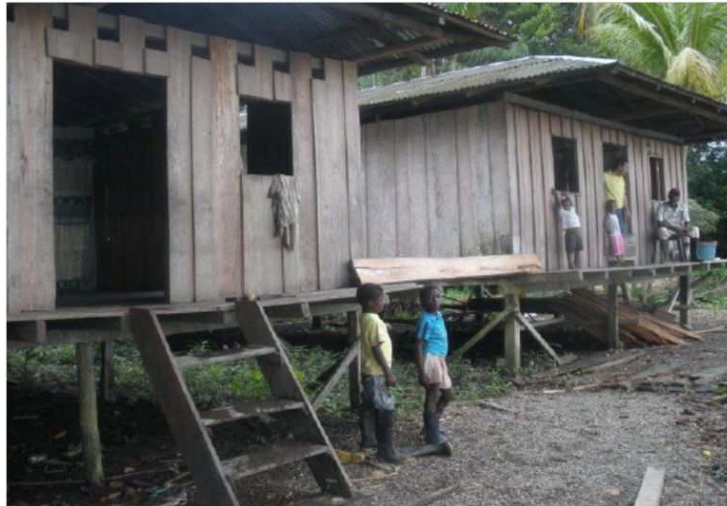
Figura 17. Construcciones típicas del municipio a nivel rural. Fuente:(González & Vargas, 2011)
