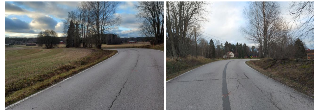
Kuva 47. Järvenpääntien länsipäädyn haastava kohtaamisnäkemä (52 m). Näkemä avautuu kohdan ympäriltä pitkältä matkalta.
